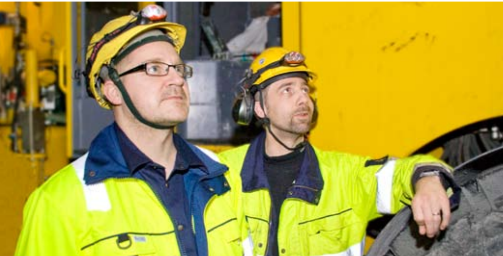
Revisando el progreso: Roger Jatko, Entrenador, LKAB (izquierda) y el operador del Boltec Tom Grundell inspeccionan la galería recién reforzada.
