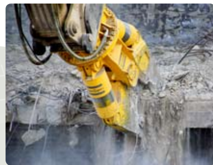
从上面切割：最大工作重量达 6,500 kg 的 Combi 系列液压剪将在 Bauma 展出。
