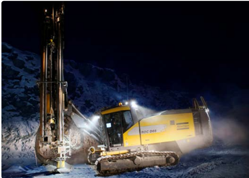
矿山上的小伙伴：SmartRig ROC D65 由于采用钻机控制系统自动控制钻进循环，将完全由计算机控制潜孔锤钻进。
