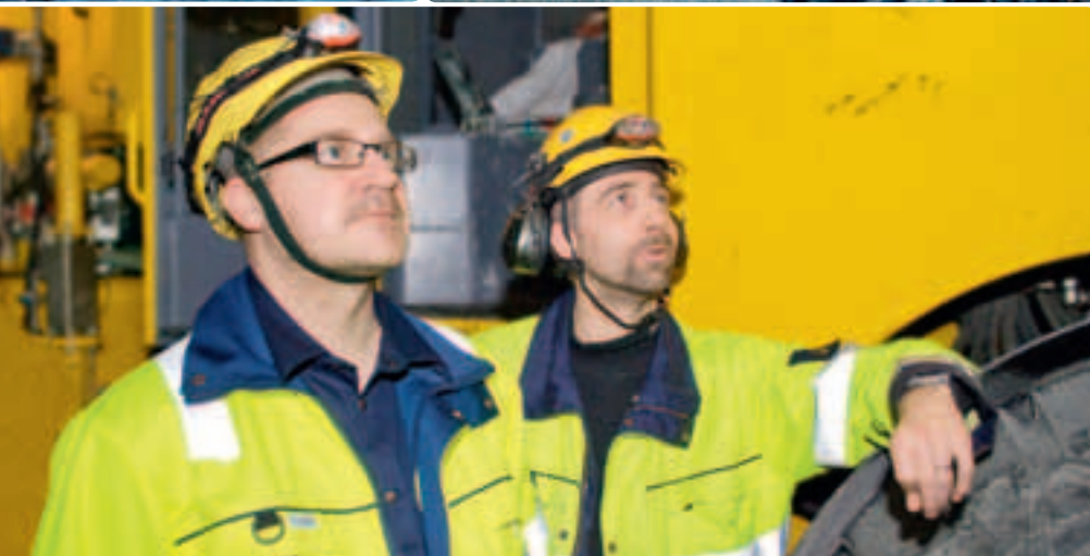
Осмотр работы: инструктор Рогер Ятко (слева) и оператор Voltec Том Грунделл проверяют только что укрепленную кровлю тоннеля.
