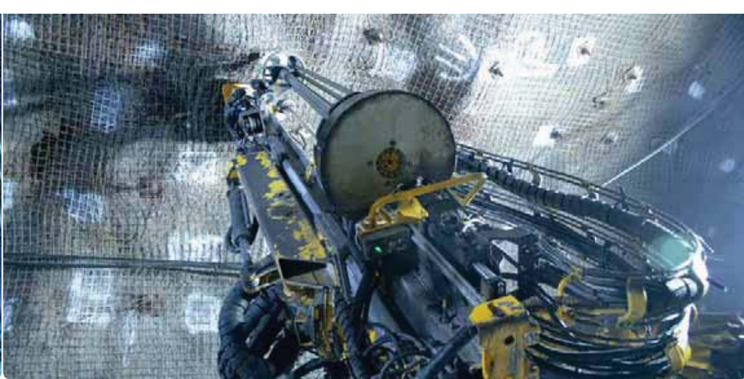
写真左上：施工を待つ、坑道に並ぶスエックスボルト 写真上：Boltec LCのドリルブーム (10本のボルトからなるカラーセルを搭載している)
