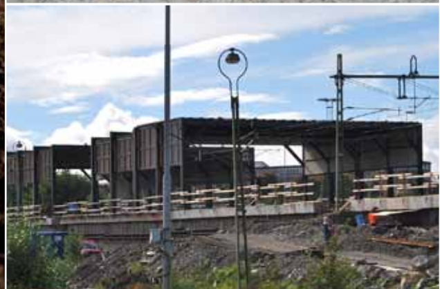
Perforando sin perturbar: Arriba, ingenieros trabajan a la madrugada; a la derecha, Johan Blumfalk, ingeniero de mina, con el sistema de perforación Elemex; más lejos, los escudos que protegerán la vía existente mientras se construye el nuevo puente para la City Line.
