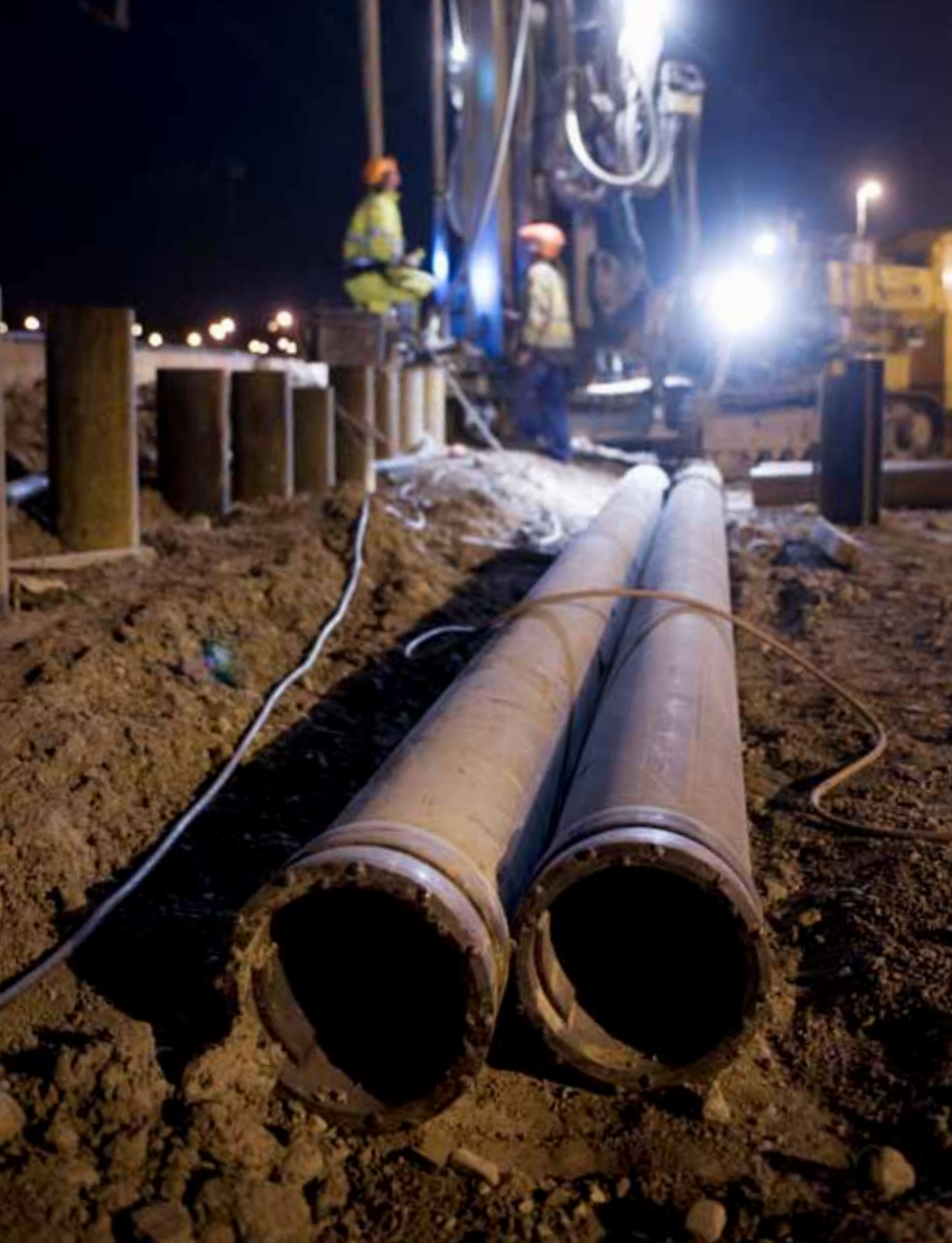
Perforando sin perturbar: Arriba, ingenieros trabajan a la madrugada; a la derecha, Johan Blumfalk, ingeniero de mina, con el sistema de perforación Elemex; más lejos, los escudos que protegerán la vía existente mientras se construye el nuevo puente para la City Line.
