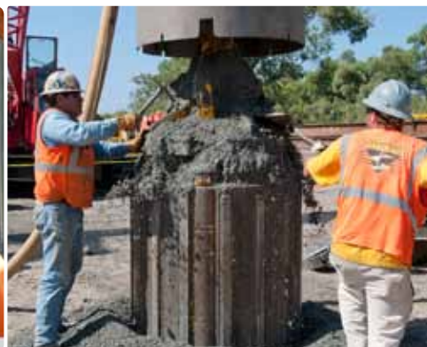
Vaciando la cesta Calyx: Lleva unos 20 minutos levantar la perforadora, remover los detritus y retornar la perforadora al pozo.
