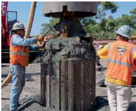
倒空萼状钻斗：提升钻斗，倒出钻渣，将钻斗放到孔内大约用 20 min。
