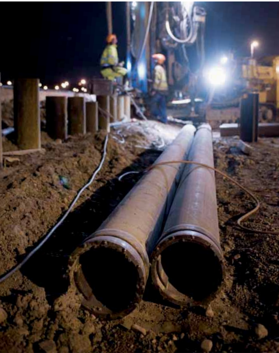
无干扰钻孔—左图：工程师们在有限的时间内工作；右上图：现场工程师 Johan Blumfalk 展示 Elemex 钻具系统；右下图：修建新的城市铁路桥梁时用防护套管保护既有铁路。
