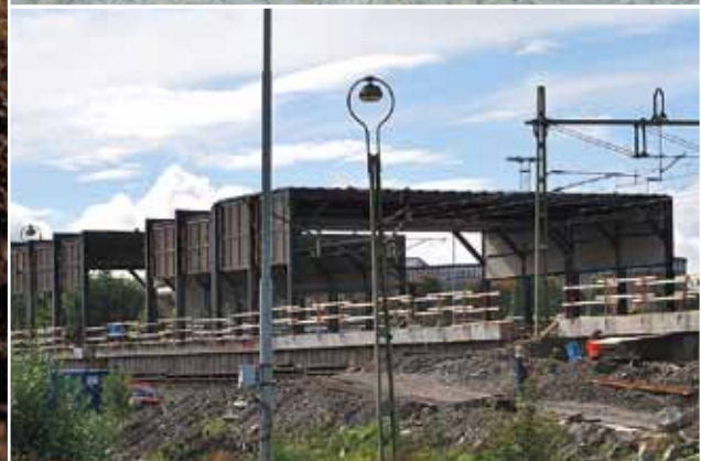
Бурение без разрушений: (вверху) инженеры за работой ночью; (вверху справа) инженер участка Йохан Блумфалк с буровой системой Elemex; (внизу справа) щиты, которые защитят существующее ж/д полотно при строительстве нового ж/д моста для поездов Сити лайн.
