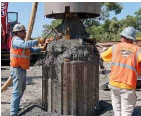
Опорожнение шламовой трубы: на поднятие кластера, вынос шлама и опускание кластера в скважину уходит 20 мин.
