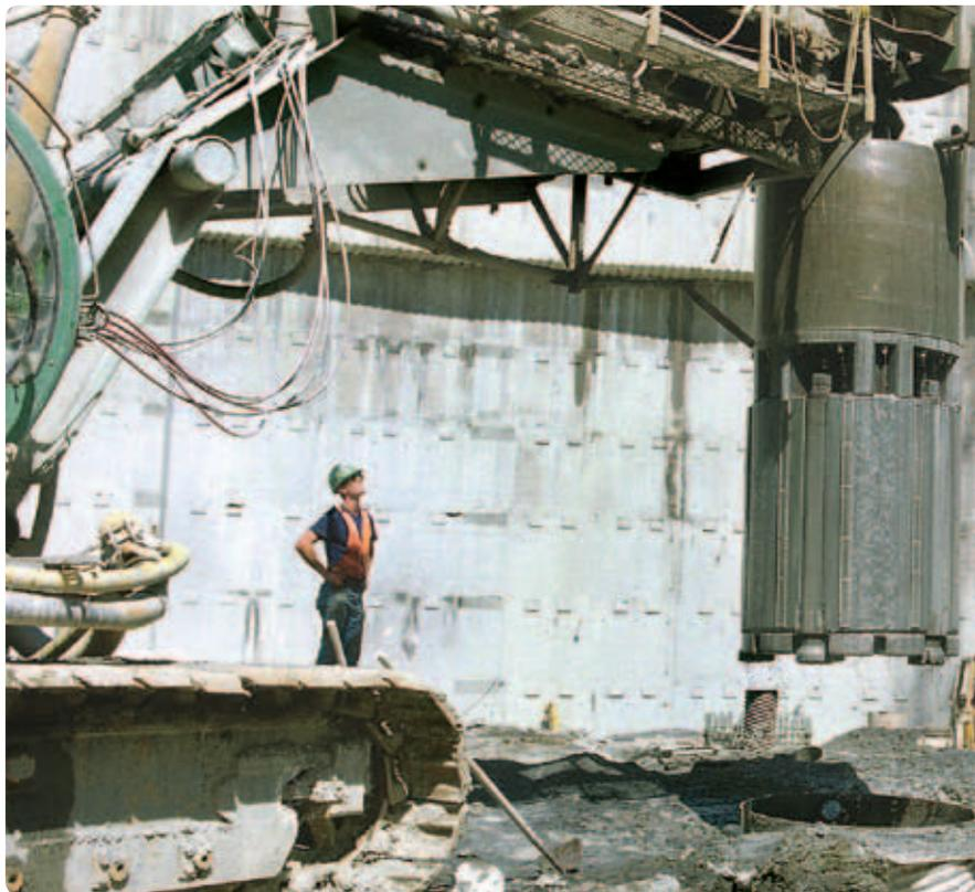
ダウンザホールハンマで構成されているクラスタードリルは、大口径さく孔が素早く簡単に出来るため、アメリカで幅広く使用されています。上記右、クラスタードリル（クレイバスケット付）を地上に引き上げている状態、左はクレイバスケットから排土しているところ
