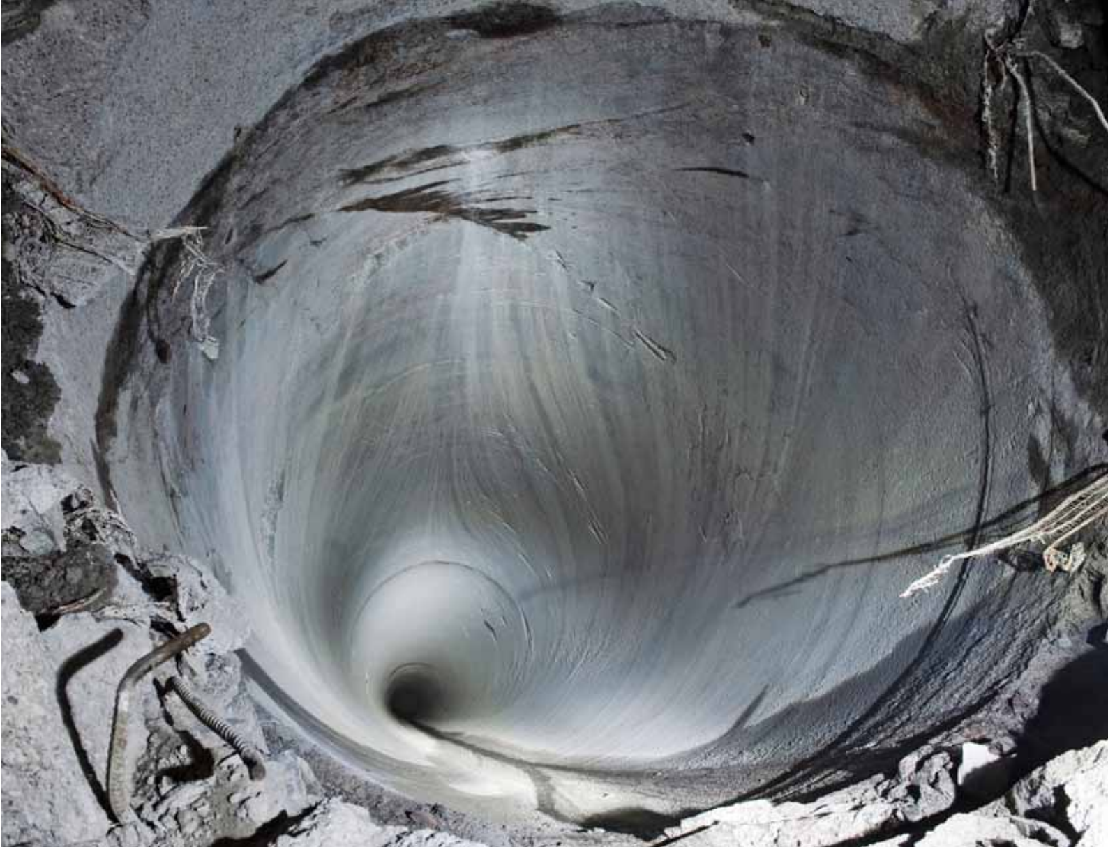
Un gran ejemplo de tecnología Raising Boring: Paredes perfectamente rectas y lisas, perforadas con el diámetro requerido perfecto.
