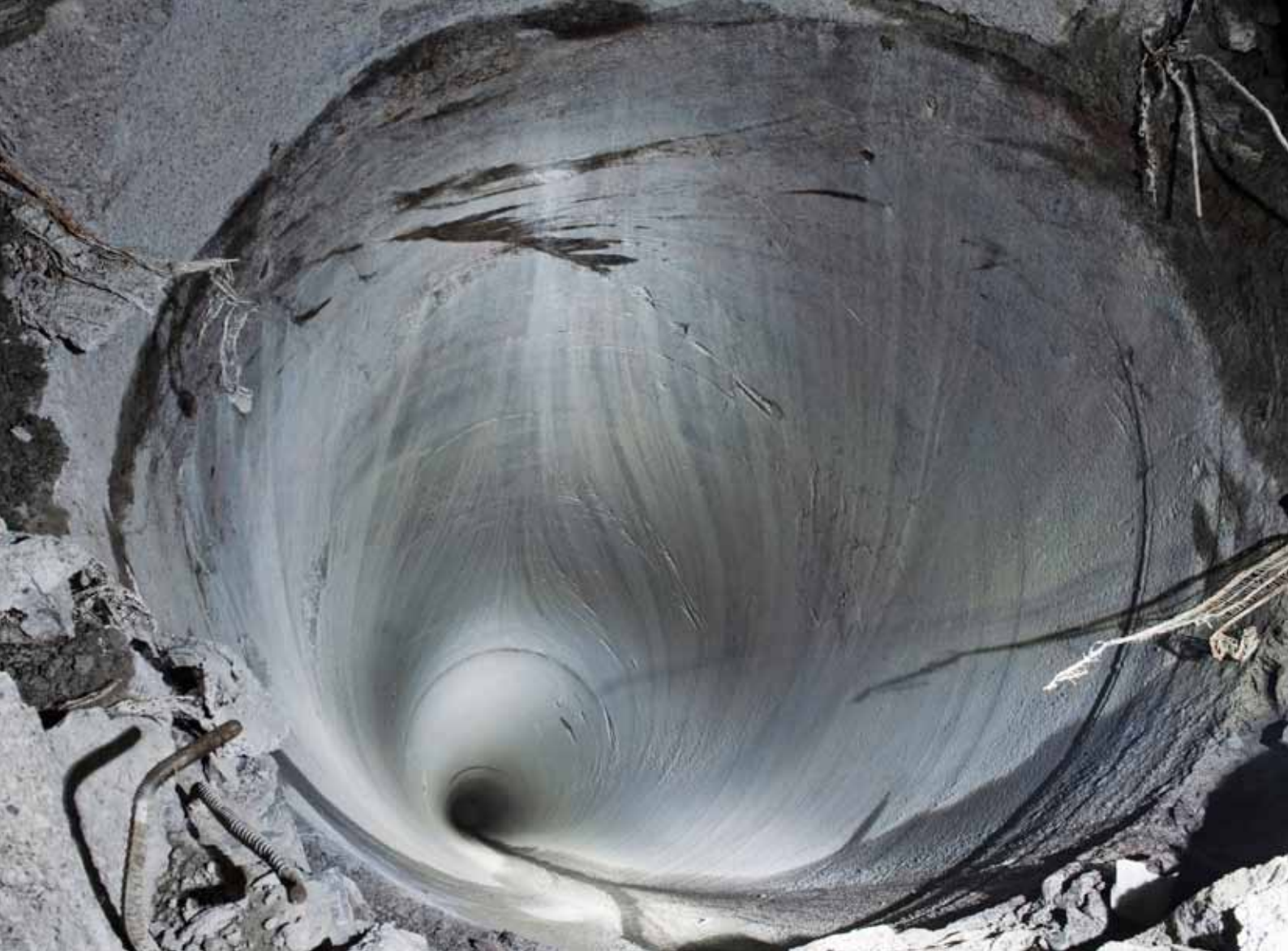
精细天井钻进技术的典型：以精确要求的直径钻出具有完美顺直度和光洁度的孔壁。
