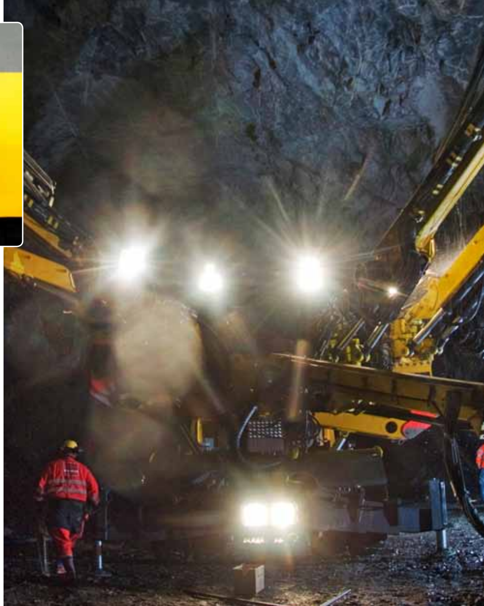
在 Kattleberg 山内部: 全电脑化的阿特拉斯·科普柯 Boomer XE4 C 掘进凿岩台车在新铁路隧道中钻预灌浆孔和爆破孔。
