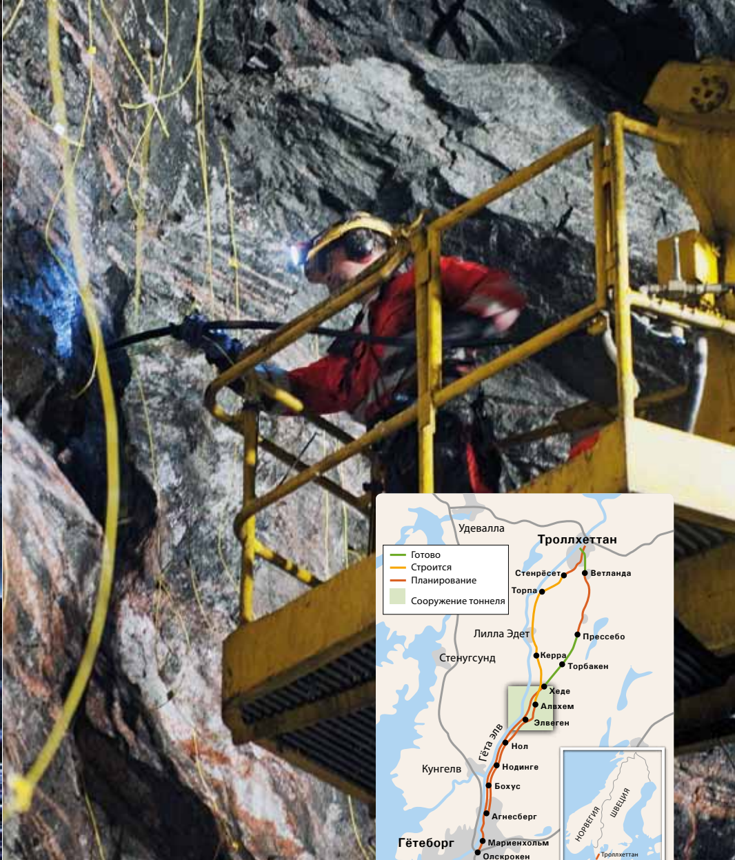
С сервисной платформы станка скважины готовятся к заряданию и взрыванию
