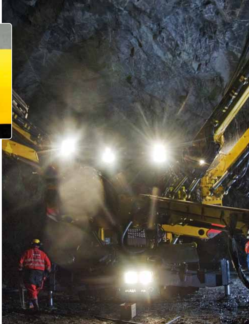
В массиве горы Каттлеберг: полностью компьютеризированный станок Atlas Copco Boomer XE4 C на бурении взрывных и цементационных скважин в выработке, которая станет тоннелем
