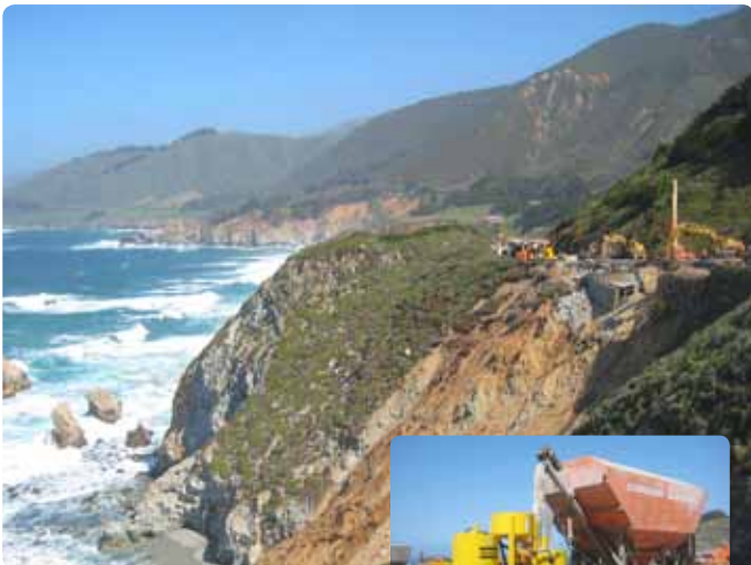
El sistema Atlas Copco Unigrout ayudando a estabilizar el camino en Big Sur.
