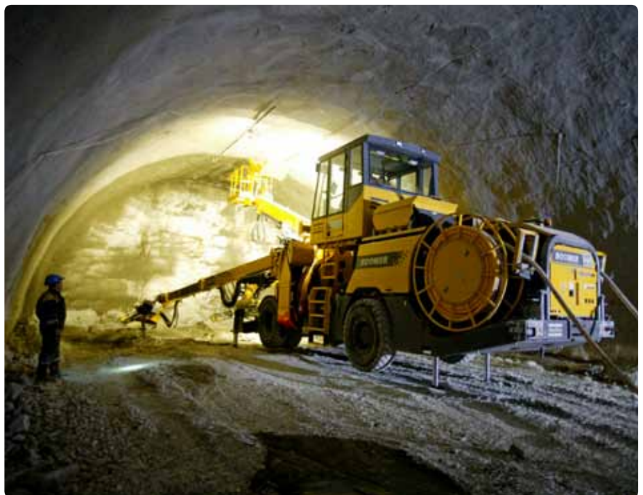
Tarea olímpica: Un Atlas Copco Boomer XE3C perforando para Bamtonnelstroy.
