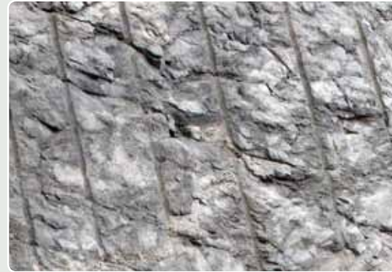
看得见的证据：能清楚地看到钻孔痕迹的事实，证明预裂孔钻孔正确，孔距近、孔直并且平行，少量装药，在缓冲孔和生产孔爆破之前起爆。
