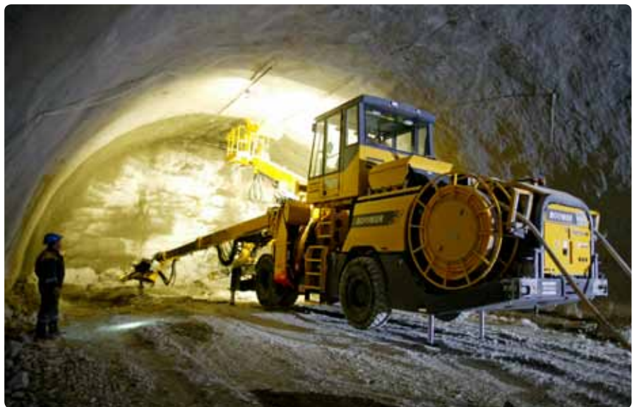
奥林匹克任务：一台阿特拉斯·科普柯Boomer XE3C为承包商Bamtunnelstroy开挖隧道。
