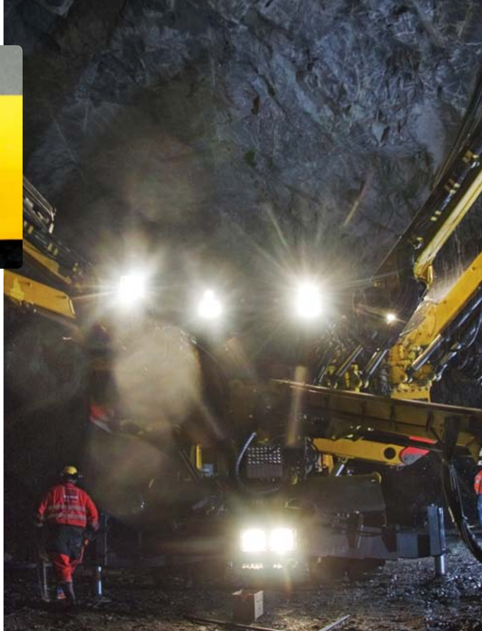
カトルベルグ山にて：新しい鉄道トンネル建設現場での、コンピュータ制御のアトラスコボ Boomer XE4 Cトンネルジャンボ。ブラストホールとプレグラウトホールをせん孔している。
