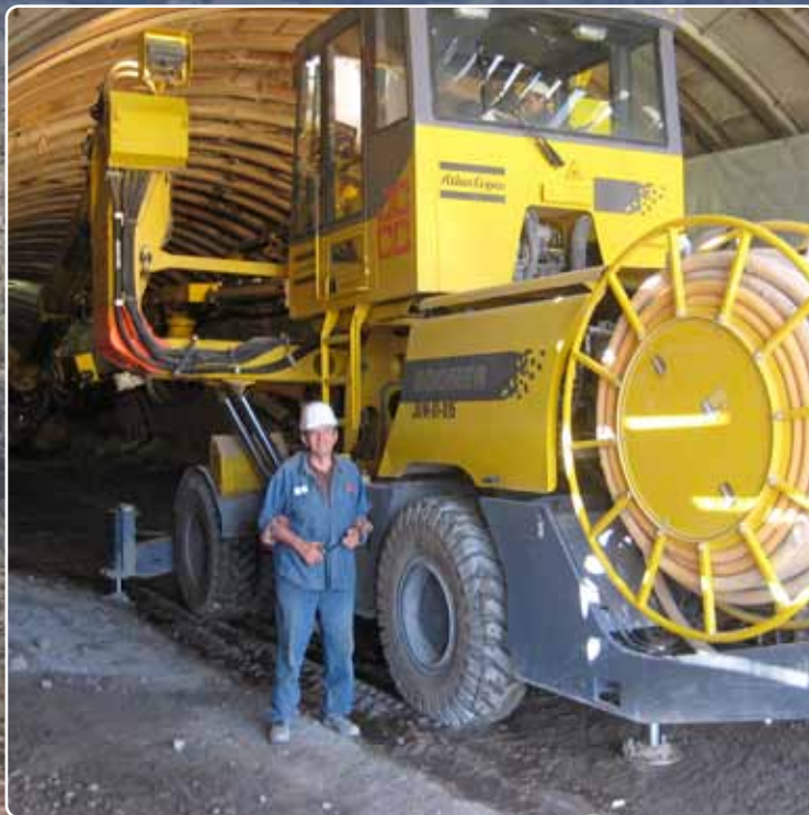
Moderna tecnología domina donde antiguamente reinaron los dinosaurios: El Boomer E2 C trabajando en soporte de roca en el Túnel 3. Y Fausto Cervini, Jefe de Producción de Túneles, con el Boomer XE3 C de tres brazos en el Túnel 1.
