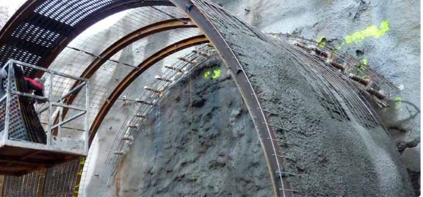
加固 Torrebasa 隧道：到目前为止，安装了 5 段管棚提供有效和快速超前支护。计划再安装 8 段管棚，每段长度为 9 m，支护 50 m 隧道。
