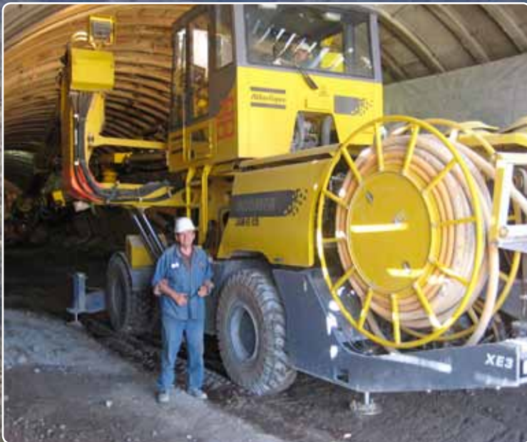
现代技术已渗透到恐龙漫步的地区：最左边图 - BOOMER E2 C 在特别困难的3号隧道进行岩石支护工作。左图 - 隧道掘进经理FAUSTO CERVINI 在1号隧道三臂钻孔台车 BOOMER XE3 C 旁边。
