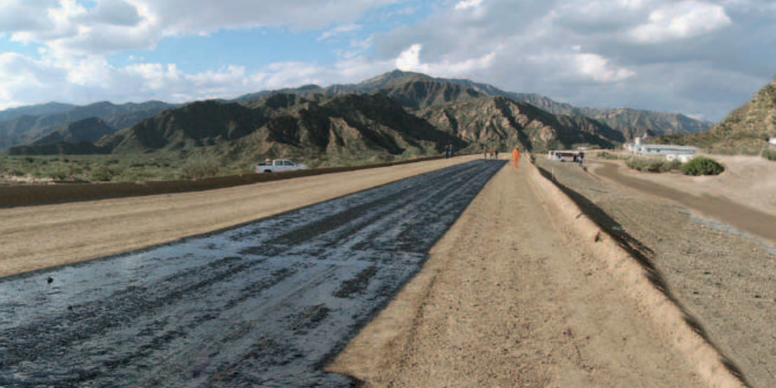
Единственная дорога: в пустыне, в 300 км до ближайшего города, JCCC полностью реализует контракт на новую 24 км трассу, включая шесть тоннелей и пять мостов.
