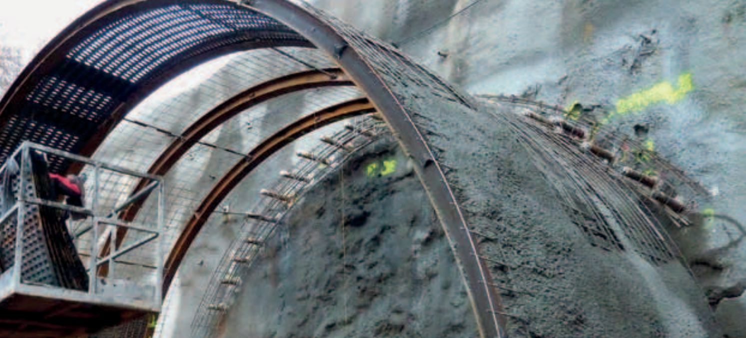
Укрепление тоннеля Торребасо: уже установлено пять зонтичных креплений свода, обеспечивающих быструю и эффективную стабилизацию перед выемкой. Планируется установка еще восьми таких конструкций длиной 9 м для укрепления оставшихся 50 м.
