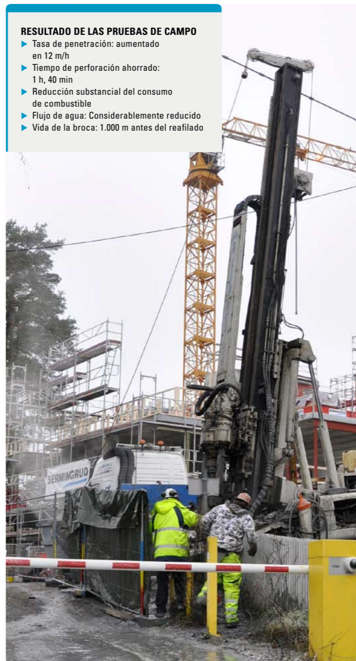
Poniendo EDGE a prueba: Aquí el equipamiento es usado para perforar nueve pozos de 500 m de profundidad para un gran complejo de apartamentos en Oslo.
