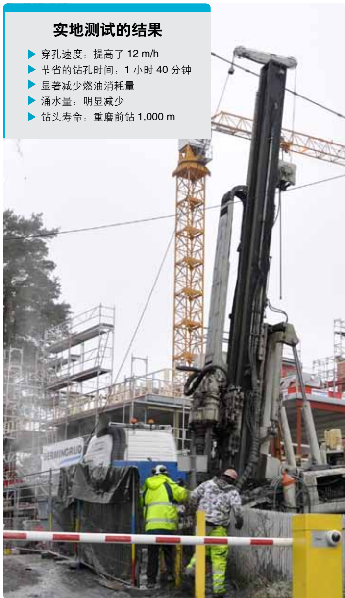
测试EDGE：在这里，阿特拉斯·科普柯的设备被用来为奥斯陆附近的一处综合公寓钻 9 口 500 m 深的井。
