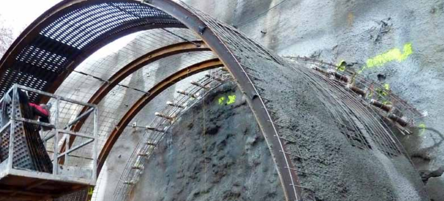
トレバットトンネルを補強する：掘削工事に先駆け、これまで5シフトのパイプルーフが設置されました。時間もかからず効果的にトンネルを支えています。さらに50m先では、9mの「アンブレラ」が8シフト計画されています。
