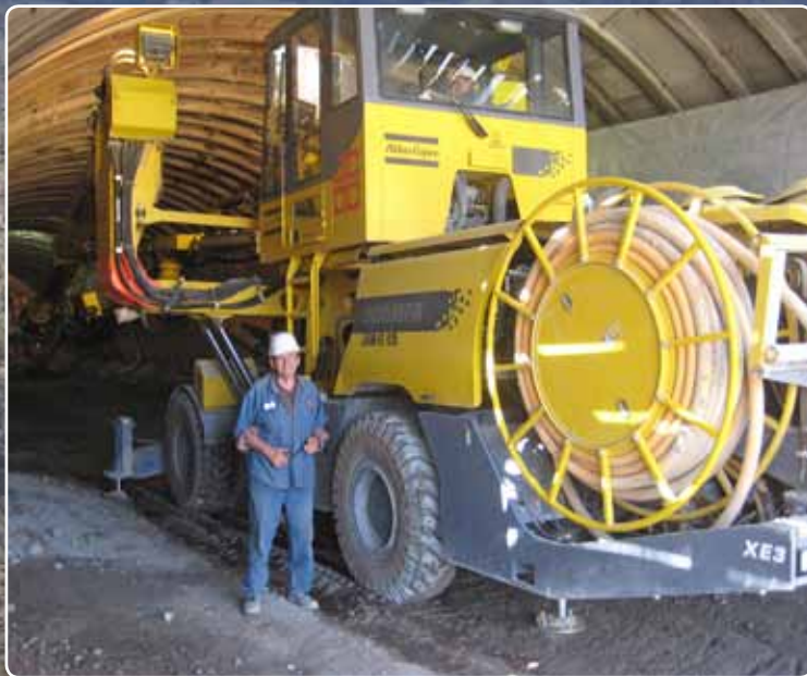
かつての恐竜繁栄の地で活躍する 近代的テクノロジー： 左から 難易度の高いトンネル3で岩 盤の補強作業中のBoomer E2 C。 トンネル1の坑内で、トンネル建設マネ ジャーのファウスト・セルビニさんと Boomer XE3 C
