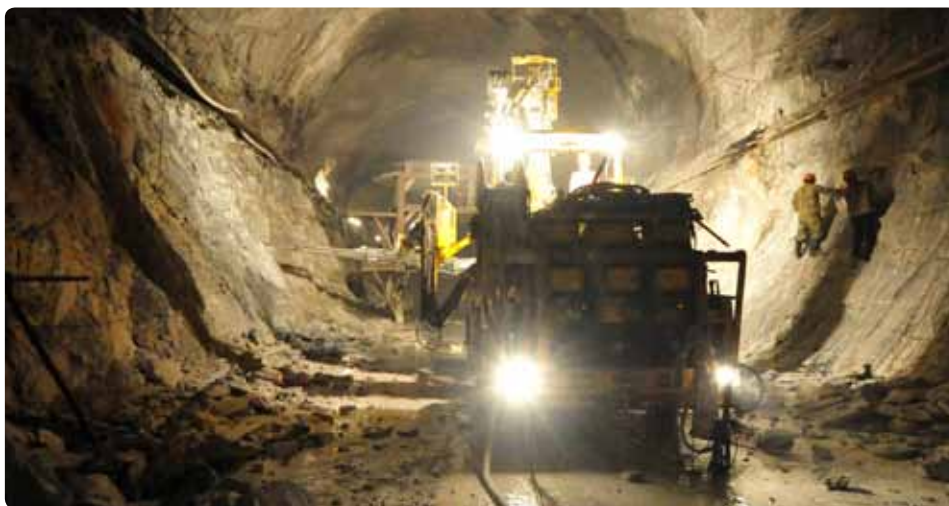
En el Curva del Yalong River: El Boomer 353 E de Atlas Copco perforando uno de los cuatro túneles de alimentación en el proyecto hidroeléctrico Jinping II. Dice el Mánager de Proyecto Quan Li: "El Boomer está hecho para este tipo de trabajo."
