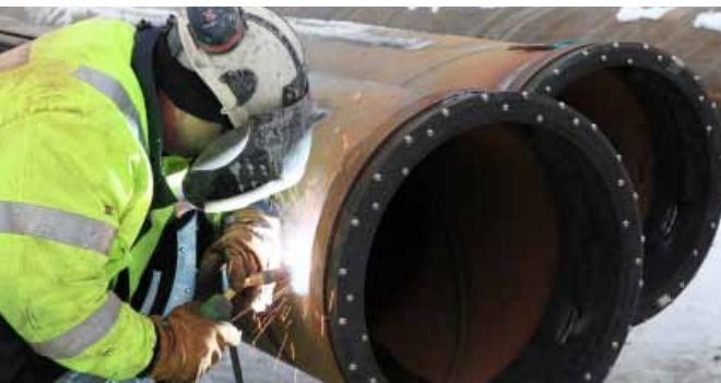
Siguiendo las agujas del reloj, desde la izquierda: Soldando la zapata del tubo de revestimiento con su broca anular sobredimensionada antes de perforar; alineando el sistema de enganche de la pared del tubo; la sarta de perforación interior retirada después de la instalación de los tubos.
