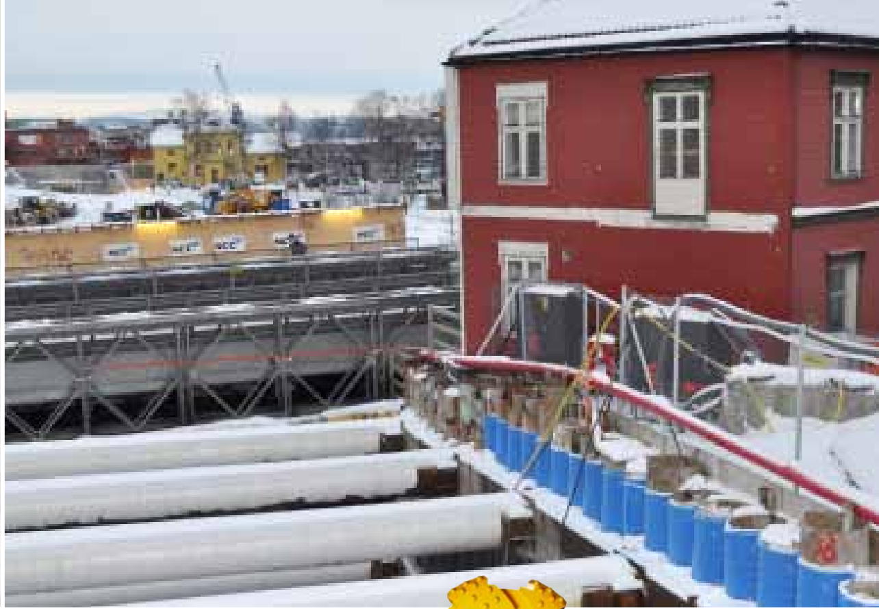
Demasiado cerca para ejecutar la obra: Uno de los edificios que fue completamente removido intacto y más tarde, puesto otra vez en exactamente el mismo lugar.
