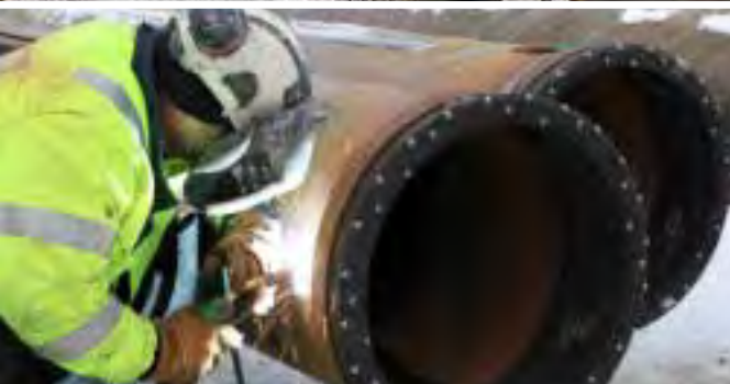
左起顺时针方向：在钻孔之前，将套管靴与加大尺寸的环形钻头焊接在一起；对正互锁的套管壁；在安装套管后回收的内钻柱。
