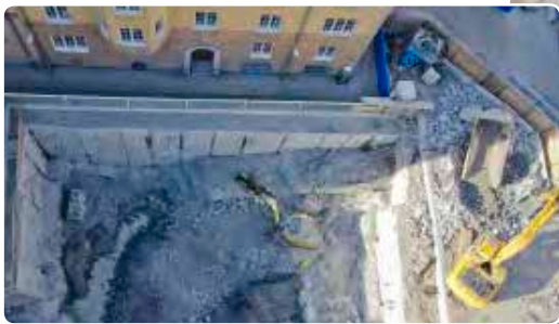
消除振动：保护附近的居民楼和右图的圣马太教堂，两者距离工地的边缘只有1米。
