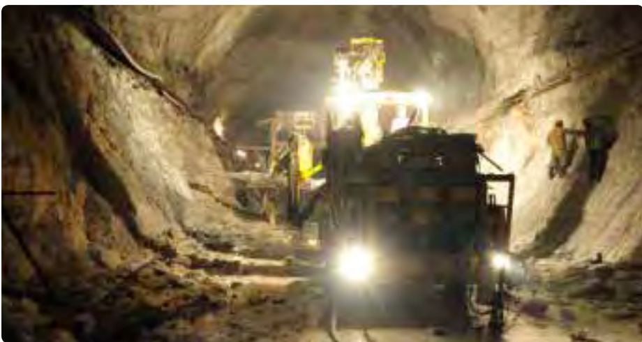
雅砻江大河湾:阿特拉斯·科普柯Boomer 353E在锦屏二级水电站工程的引水隧洞进行施工。项目经理李权说:“Boomer是专门为这类工程设计的。”
