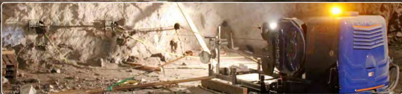
保持斯德哥尔摩的安静。SpeedCut能锯下岩石，修建新的地铁隧道，而且不会产生扰民的噪声。
