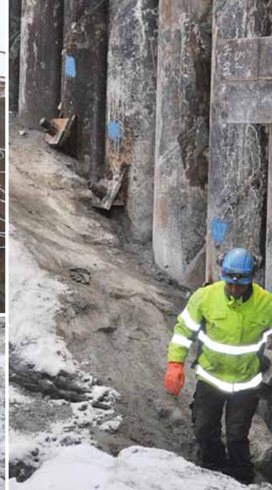
Хороший результат: норвежский инженер осматривает глинистый грунт перед стенкой из труб.
