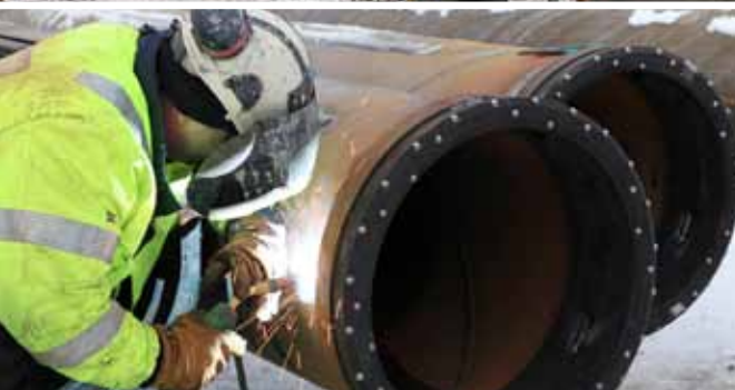
Сварка башмака обсадной трубы с увеличенной кольцевой коронкой перед бурением; выравнивание блокировочной обсадной стенки; выбранный внутренний буровой став после установки труб.
