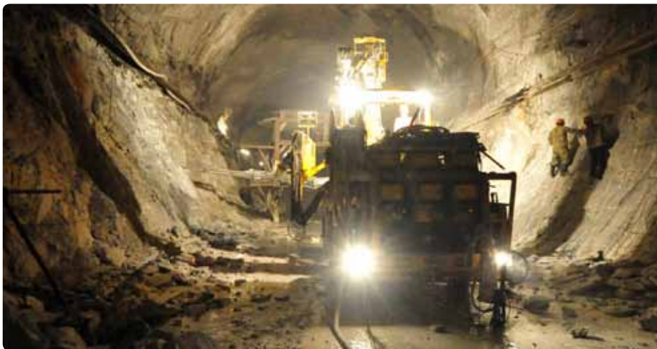
В излучине реки Ялонг: станок Atlas Copco Voomer 353 E на проходке одного из четырех подводящих тоннелей проекта ГЭС Джинпин II. Говорит менеджер проекта Куан Ли: "Voomer именно для такой работы".
