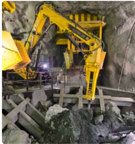
Noticias de impacto: El quebrantador RB700 XD trabajando en la nueva zona de trituración de roca.
