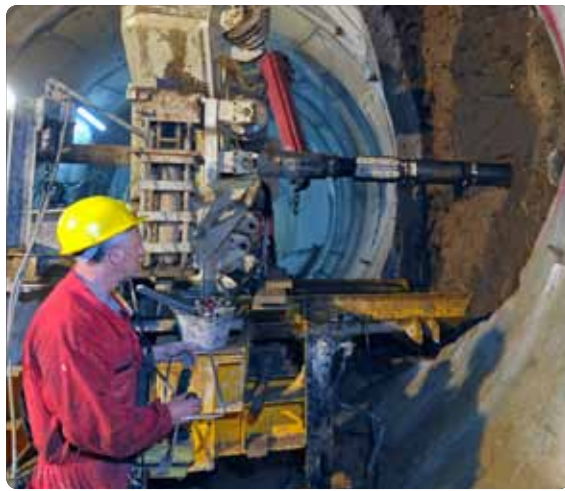
Perforando el pozo piloto: Se perfora un pozo de 311 mm en la pared del túnel donde se instalará el ducto de alivio. En el lado opuesto se acopla un escariador a la sarta de perforación y, tirando de vuelta hacia el raiseborer machine, la apertura es escariada hasta el diámetro de 3,5 m.
