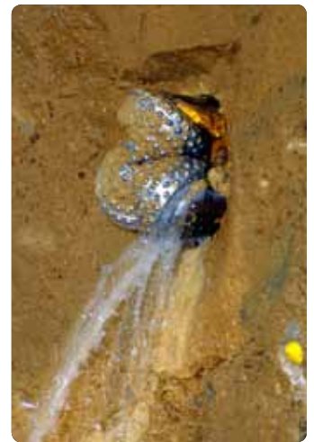
Perforando el pozo piloto: Se perfora un pozo de 311 mm en la pared del túnel donde se instalará el ducto de alivio. En el lado opuesto se acopla un escariador a la sarta de perforación y, tirando de vuelta hacia el raiseborer machine, la apertura es escariada hasta el diámetro de 3,5 m.
