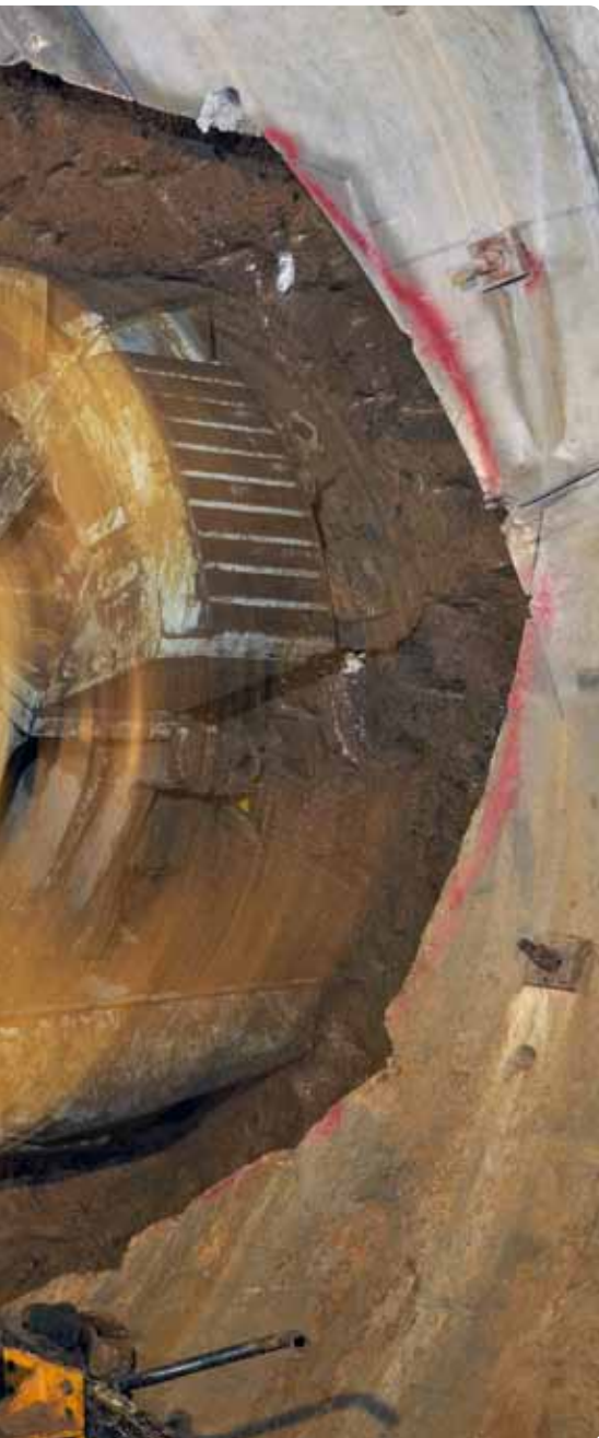
Perforando el pozo piloto: Se perfora un pozo de 311 mm en la pared del túnel donde se instalará el ducto de alivio. En el lado opuesto se acopla un escariador a la sarta de perforación y, tirando de vuelta hacia el raiseborer machine, la apertura es escariada hasta el diámetro de 3,5 m.
