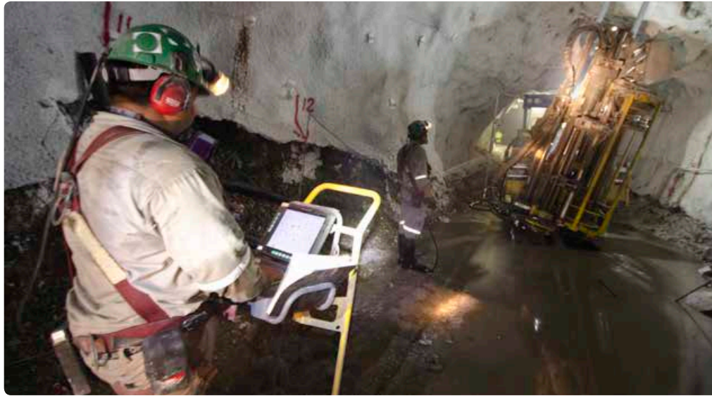
工地上的多种设备：带有钻机就位功能和钻孔遥控控制盘的 Simba M4 C 中深孔凿岩台车。
