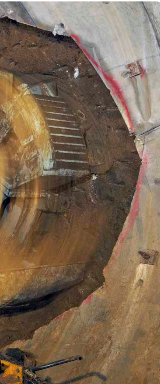
钻先导孔：在隧道壁安装减压管的地方钻直径为 311 毫米的孔。在相反一侧，扩孔钻头连接到钻柱上，向钻机方向拉扩孔钻头，将通风洞的直径扩大到 3.5 米。
