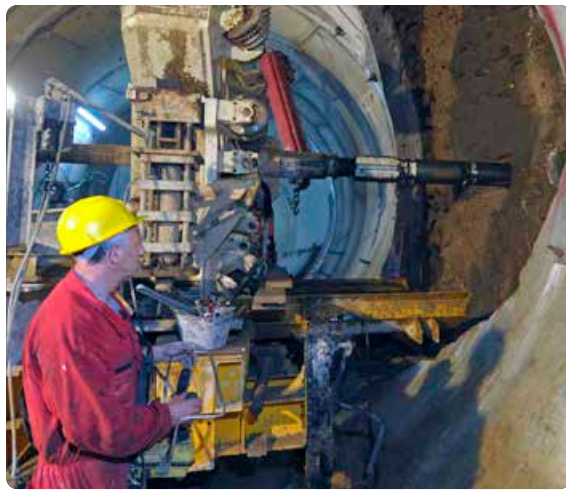
钻先导孔：在隧道壁安装减压管的地方钻直径为 311 毫米的孔。在相反一侧，扩孔钻头连接到钻柱上，向钻机方向拉扩孔钻头，将通风洞的直径扩大到 3.5 米。
