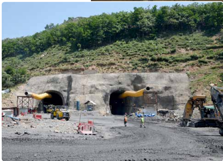
唯一的入口：由于双线隧道没有导坑，8.5公里长的 Qazigrund-Banihal 隧道的全部材料和设备必须通过4个隧道口运送到掌子面。导致由极其多变的岩石状况构成的隧道施工时间延长。
