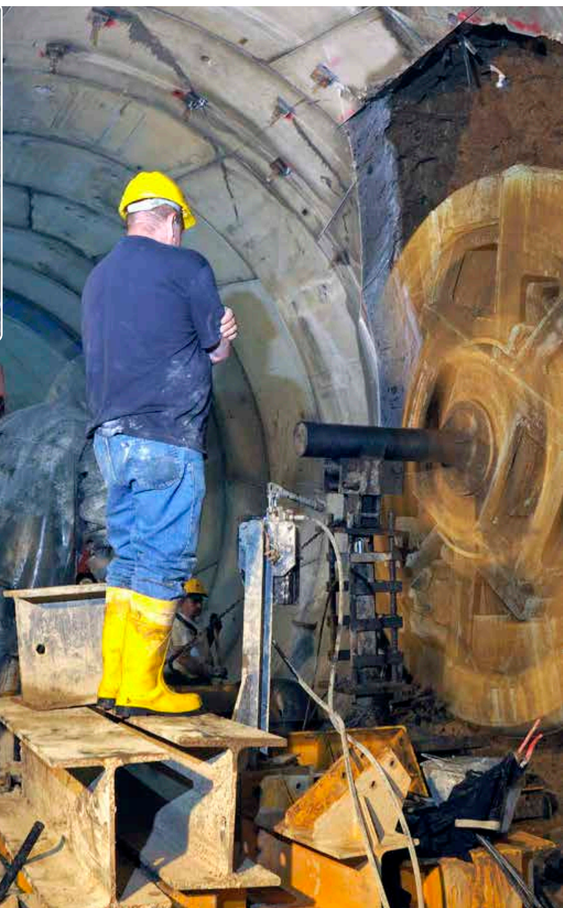
天井钻机在工作：隧道掘进工程师们用阿特拉斯·科普柯罗宾斯53RH天井钻机开挖通风洞，从那不勒斯市地下30—40米的深处释放新地铁线路内的气压。左上图是一个已经完工的通风洞。
