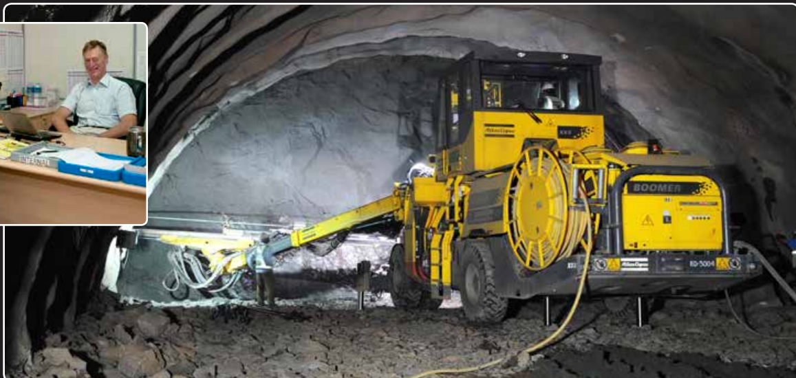
从零开始培训: 30名操作手在进行了阿特拉斯·科普柯熟练操作手课程之后, 学习操作Boomer凿岩台车。照片为在隧道北掌子面的Boomer XE3 C。
