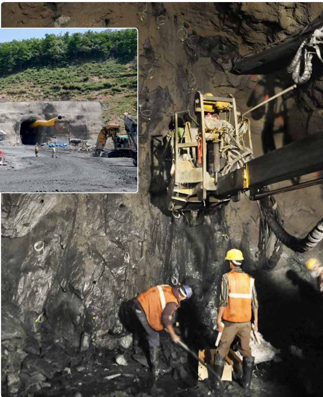
唯一的入口：由于双线隧道没有导坑，8.5公里长的 Qazigrund-Banihal 隧道的全部材料和设备必须通过4个隧道口运送到掌子面。导致由极其多变的岩石状况构成的隧道施工时间延长。
