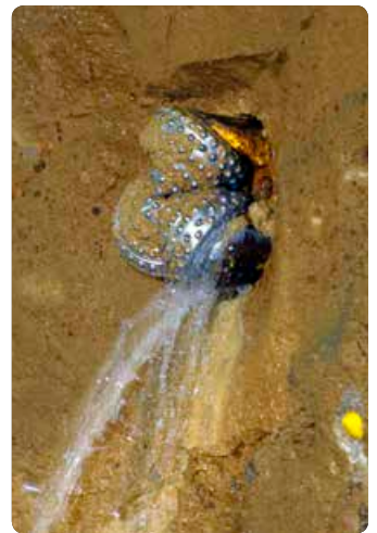
钻先导孔：在隧道壁安装减压管的地方钻直径为 311 毫米的孔。在相反一侧，扩孔钻头连接到钻柱上，向钻机方向拉扩孔钻头，将通风洞的直径扩大到 3.5 米。
