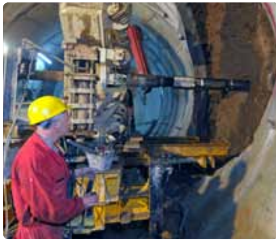
Бурение пилотной скважины: скважины \varnothing 311 мм бурится в стене тоннеля, где ставится выпускной канал. Справа: монтаж расширителя к буровому ставу. Подавая в обратном направлении, отверстие разбуривается до \varnothing 3.5 м.
