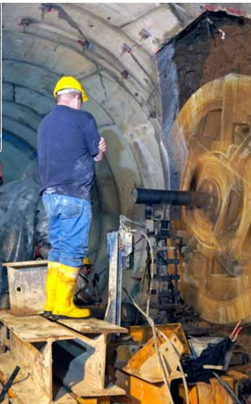
Robbins 53RH в действии: инженеры-тоннелепроходчики используют Atlas Copco Robbins 53RH для сооружения отверстий для сбрасывания давления воздуха внутри новой подземки, пролегающей на 30-40 м под Неаполем. Слева вверху – законченное отверстие.
