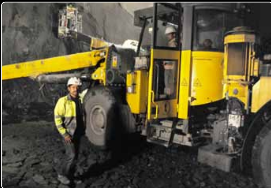
По графику: сервисный инженер Atlas Copco Абхой Бисвас у станка Atlas Copco Boomer E2 С.
