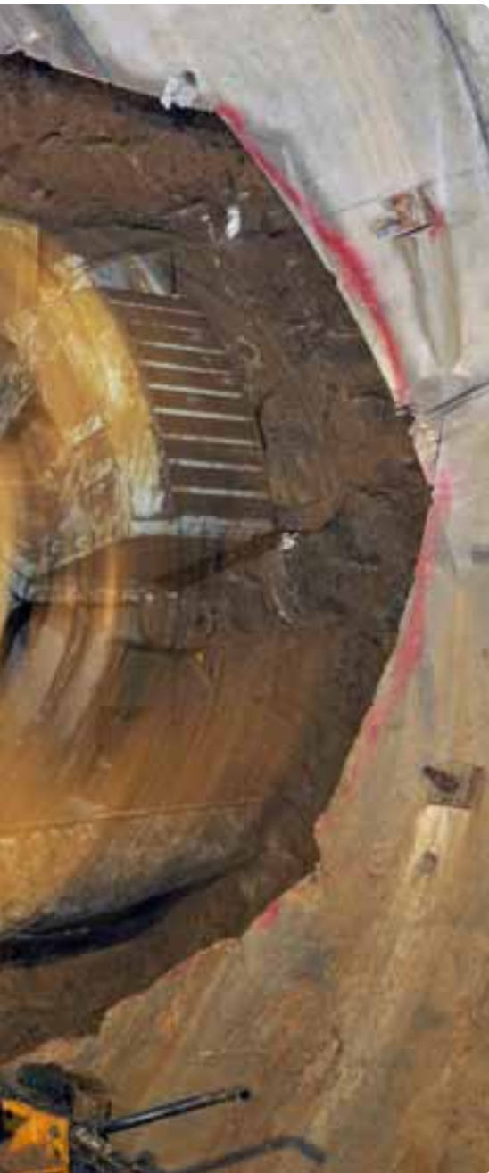
Бурение пилотной скважины: скважины \varnothing 311 мм бурится в стене тоннеля, где ставится выпускной канал. Справа: монтаж расширителя к буровому ставу. Подавая в обратном направлении, отверстие разбуривается до \varnothing 3.5 м.
