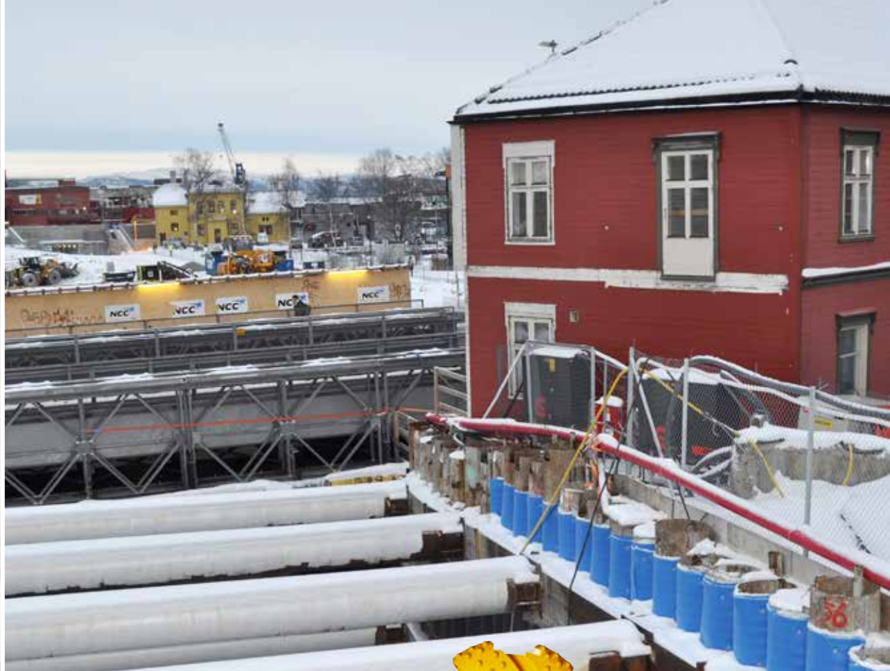
近すぎる距離:文化財の建築物はそっくりそのまま移設され、工事後もとの場所に戻されました。
