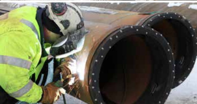
時計回りに左から:さく孔前に、オーバーサイズのリングビット付きケーシングシューを溶接する; ケーシング側面の連結部分を揃える; パイプ打設後に回収されたドリルロッド
