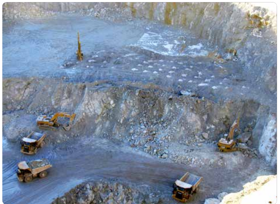
フルスピードで進む作業:アトラスコブコリグはムルグル鉱山でさく孔から運搬まで、あらゆる作業をこなします。ベンチは10m高で余掘りは2m、鉱石には4×4m、ズリには5×5mのパターンを採用しています。
