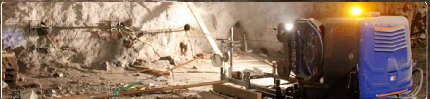
ストックホルムの静穏を守る:SpeedCutは気になる振動を起こさず、新しい地下鉄トンネル建設用に岩石を切断しています。
