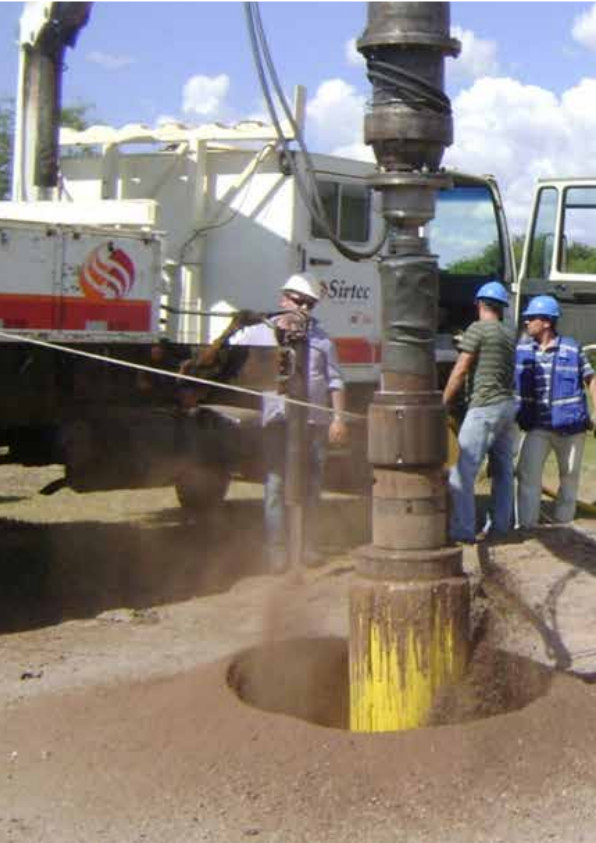
ユーティリティパワーポールドリル120では口径810~3005mmをさく孔できます。
