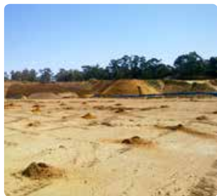
钻孔布置已经完成！通过全自动远程控制钻探，共完成15个钻孔，一共3列，每列5个钻孔。
