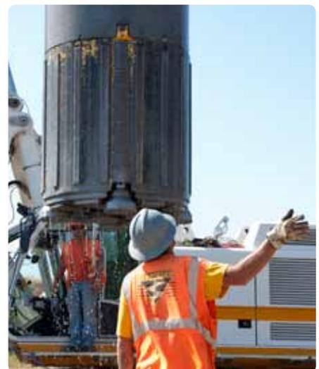
*...y una perforadora de cluster consistente en siete martillos para trabajos en fundaciones en USA.*
