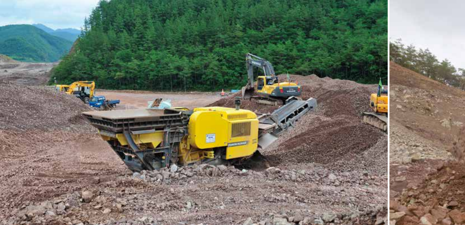
环保型采石作业：Wonjin Construction 公司利用 Powercrusher PC 4 型破碎机为韩国的基础设施扩建提供混凝土原料，这张照片拍摄于在建的30号公路附近的 Andong 采石场。
