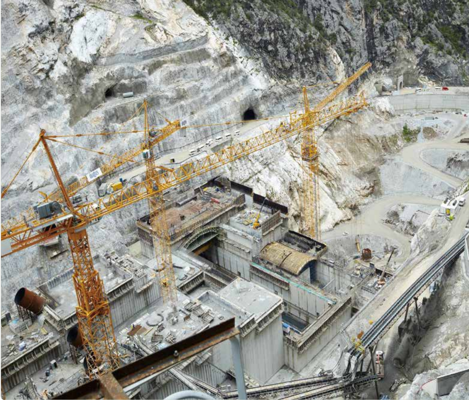
注浆施工的巨大挑战：博亚巴特大坝的建设将大大推动了土耳其的水力发电事业，但在密封和稳定大坝方面的工程量巨大。
