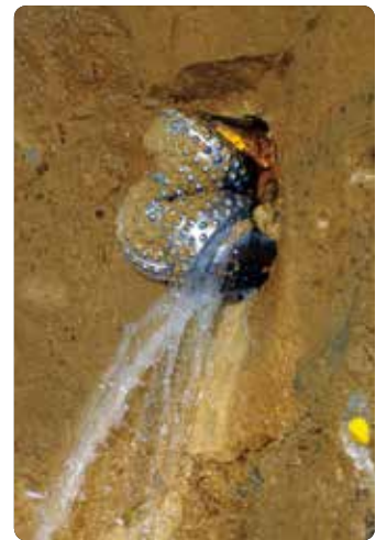
パイロットホールのさく孔:圧力解放用のダクトを設置するため、トンネルの壁面に径311mmの孔をさくします。貫通すると、リーマーをドリルロッドに装着した後、レイズボーリングリグに向かってリーミングしながら戻します。開口部は直径3.5mに拡幅されます。
