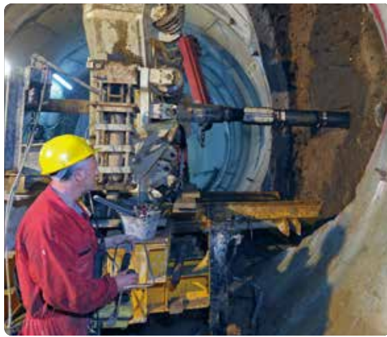
パイロットホールのさく孔:圧力解放用のダクトを設置するため、トンネルの壁面に径311mmの孔をさくします。貫通すると、リーマーをドリルロッドに装着した後、レイズボーリングリグに向かってリーミングしながら戻します。開口部は直径3.5mに拡幅されます。
