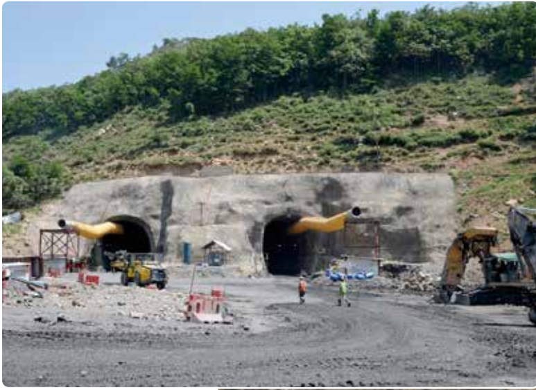
唯一の入口:8.5km長のカジグンド-バニハルトンネルには、アクセストンネルがないことから、材料と機材を切羽へ運ぶのは4か所の坑口から行われました。岩盤の構成も複雑で、そのため工期が長くなりました。
