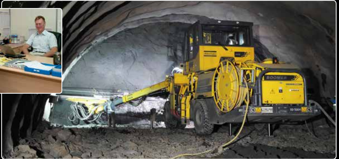
ゼロからのトレーニング:アトラスコブコ マスタードリラープログラムの研修を受け、30人のオペレータがブーマーの操作を習得しました。写真:北坑口工区でのブーマーXE3 C
