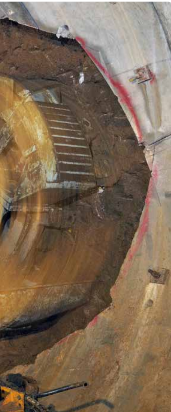
パイロットホールのさく孔:圧力解放用のダクトを設置するため、トンネルの壁面に径311mmの孔をさくします。貫通すると、リーマーをドリルロッドに装着した後、レイズボーリングリグに向かってリーミングしながら戻します。開口部は直径3.5mに拡幅されます。
