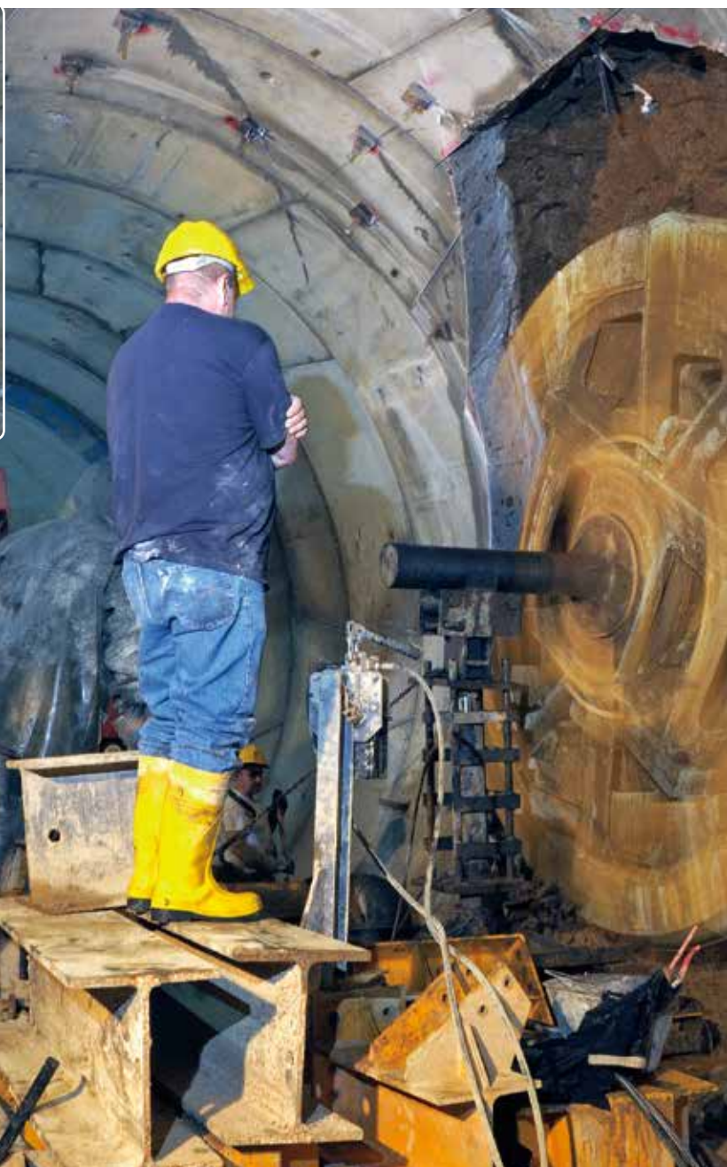
作中のレイズボーリングリグ:ナポリ市の地下30~40メートルを走る新しい地下鉄内部にて、トンネル技術者と、アトラスコプコ レイズボーリングリグ ロビンズ53RH レイズボーリングリグ。リグは、トンネル内の圧力を下げるための開口部をさく孔中。写真左上、完成した開口部。
