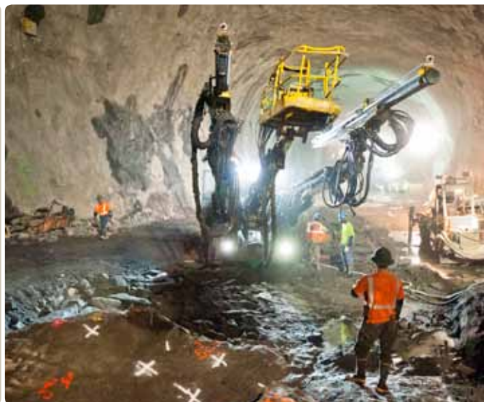
Comenzando arriba: El Boomer E2 C durante la perforación de la galería de avance superior.
