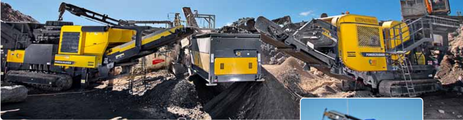
Flota de potencia: En la obra de reciclado Boral, en la isla Kooragang, MES ha instalado un Powercrusher PC 6 y una unidad móvil de triturado PC 21 así como una unidad de zarandeo HCS 5515.
