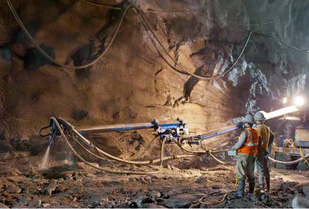
Reforzando la roca: Usando el equipo Suprema de Atlas Copco MEYCO, se aplicaron tres capas de shotcrete, dos capas de una mezcla reforzada con fibra que incluye un superplastificante, antes y después del empernado, mas una tercera cobertura sin fibra antes de la aplicación de la membrana impermeable de PVC. Juntas, las capas llegaron a un espesor mínimo de 250 mm en toda la superficie.
