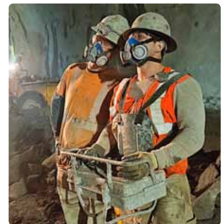
Concentración total: Operadores de MEYCO aplicando la capa final de shotcrete en una pared con el control remoto de la máquina Suprema.
