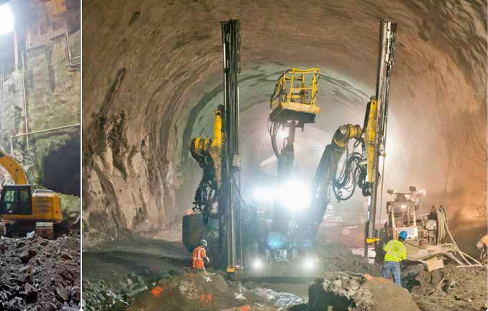
北井的台阶式掘进：必须使用Boomer T1 D掘进北井的深部并为Boomer EC2（见以上）开拓出充足空间，以便开始垂直钻孔。
