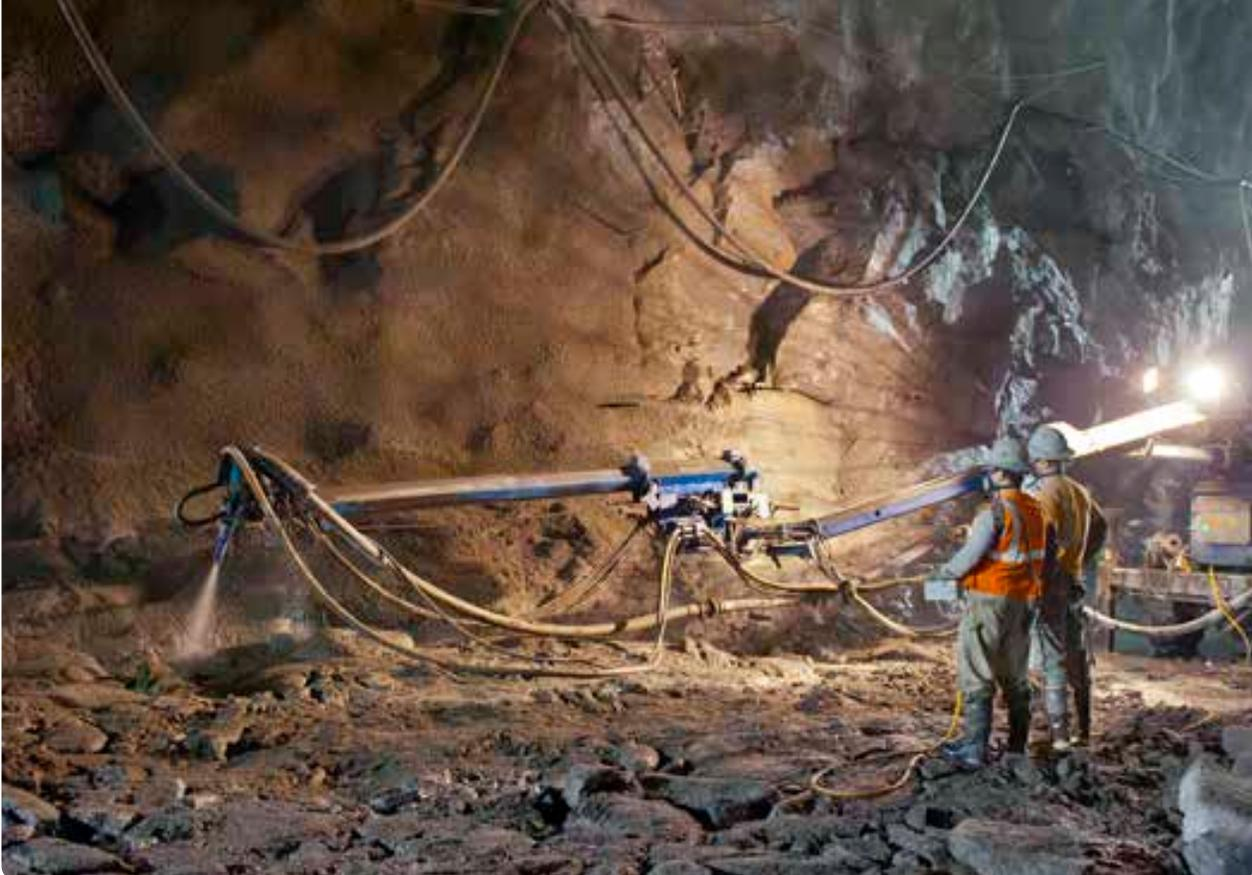
加固岩石：使用阿特拉斯·科普柯MEYCO生产的Suprema喷浆设备喷射三层喷浆混凝土。锚杆支护前后喷射的两层为添加有超塑化剂的钢纤维强化混凝土，铺设PVC防水膜之前还需喷射第三层无纤维涂层。这三层总计形成厚度最小为250mm的防护层。
