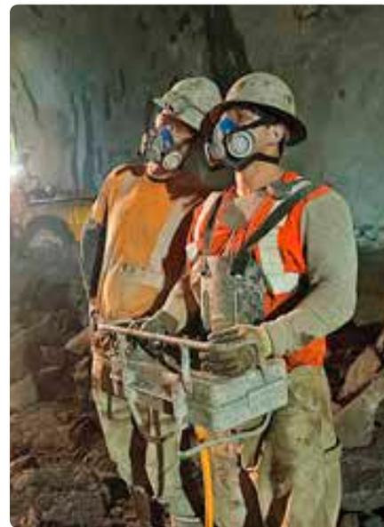
全神贯注：MEYCO操作手使用Suprema喷浆机远程喷射最后一层喷浆混凝土。
