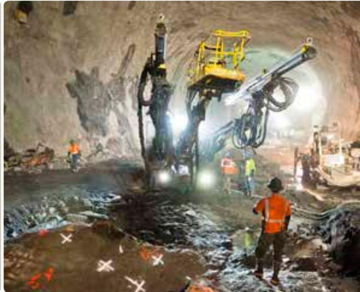
Boomer EC 2在建设硐室顶部导坑时的工作模式。
