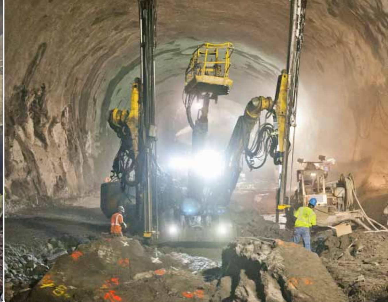
Поуступная выемка Северного ствола: пришлось использовать компактную установку Boomer T1 D для расширения нижнего уровня ствола, чтобы создать необходимое рабочее пространство для установки Boomer E2 C и начать вертикальное бурение.
