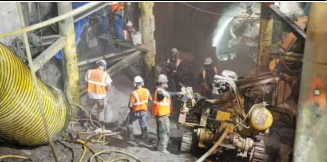
Главная трудность: установка компактного FlexiROC T30 во входном стволе у северного конца секции 86-й Улицы.
