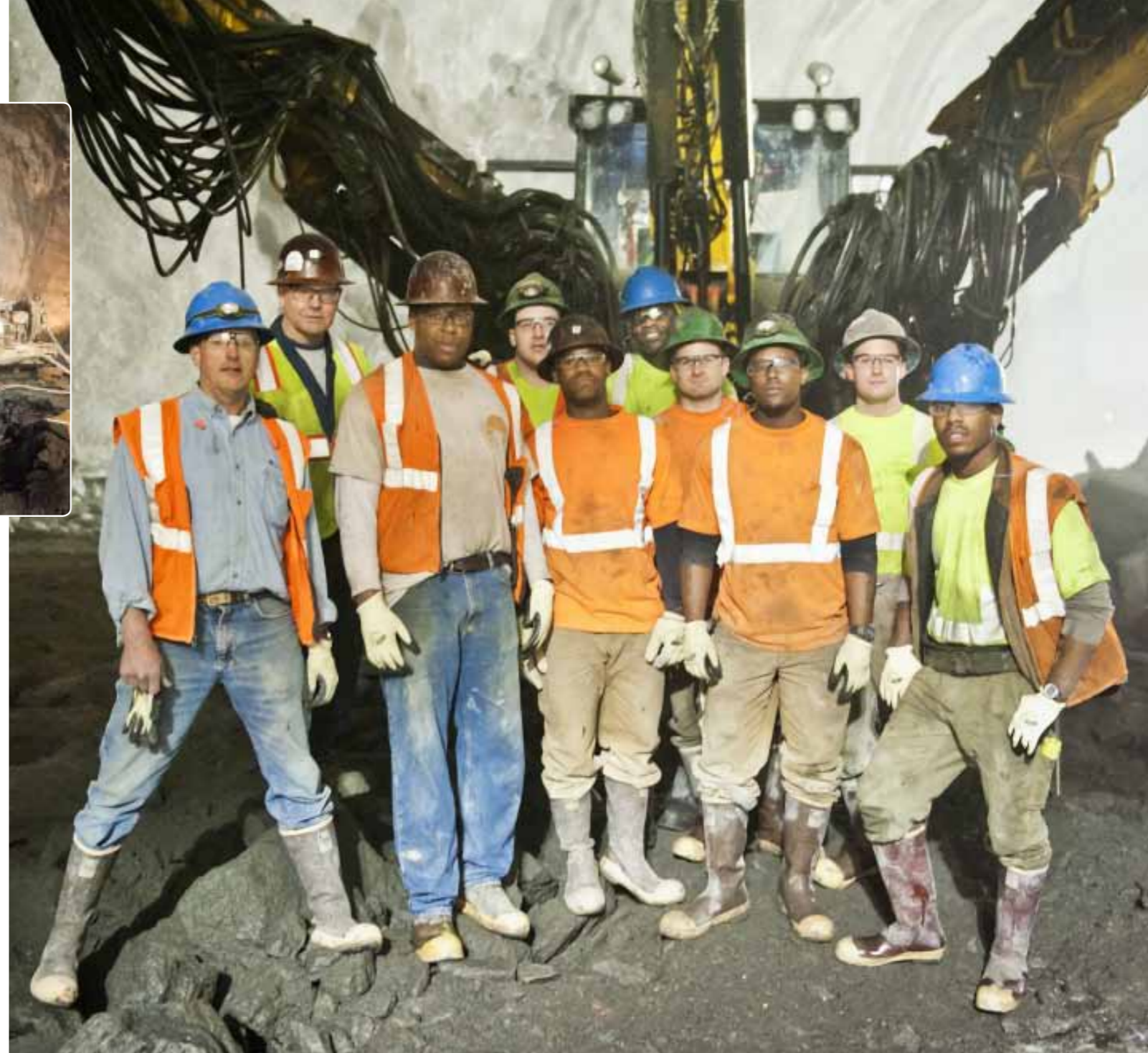
Создавая историю: члены бригады Skanska-Traylor и проходчики-подрядчики Нью-Йорка (здесь их называют "подземщиками"). Фото на память при строительстве новой подземки 2-й Авеню под улицами Манхэттена. Сзади – буровая установка Atlas Coraco Bommer E2 C, спущенная с улицы для выемки камеры для новой станции 86-й Улицы.
