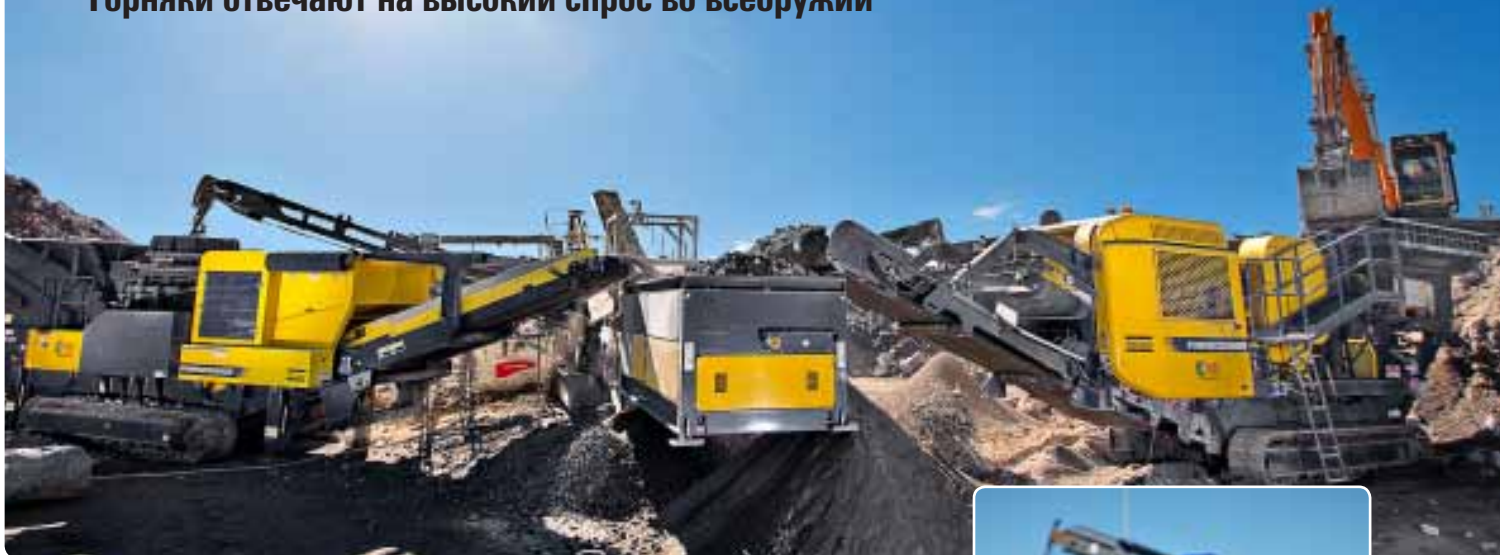
Мощный парк: на площадке переработки Борал на о-ве Кураганг MES установила обе мобильные дробилки Powercrusher PC 6 и PC 21 и грохот HCS 5515.
