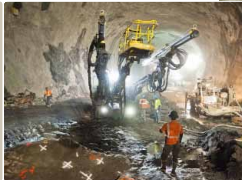
Подготовка: Boomer E2 при обустройстве верхней части камеры.
