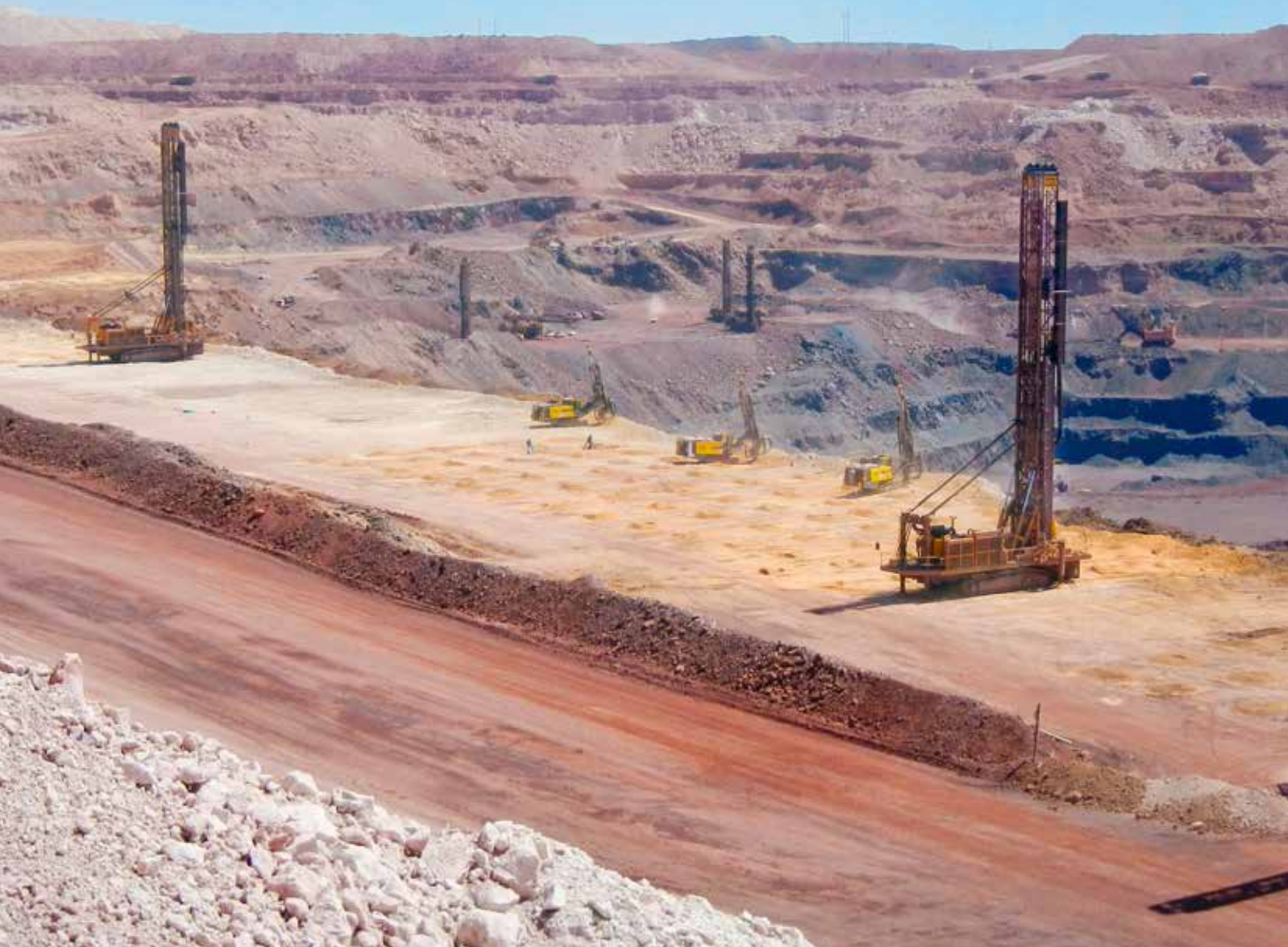
シシエンの広大な鉄鉱石鉱山の概観:シシエン鉱山で発破孔をせん孔するPit Viper 351と切羽端のさく孔を行うROC L8
