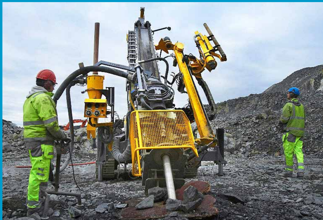
RCドリリングに貢献する:新型Explorac 100はコンパクトでしかもパワフルです。自動ロッドハンドリングシステム搭載且つ現場の作業員の安全性も考慮されています。
