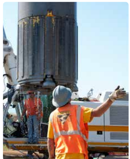
USAのトンネル基礎工事には7本のハンマを装備したクラスタドリルが使用されました。
