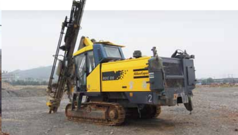
... perforando para extraer agregados de piedra caliza con el FlexiROCT40...
