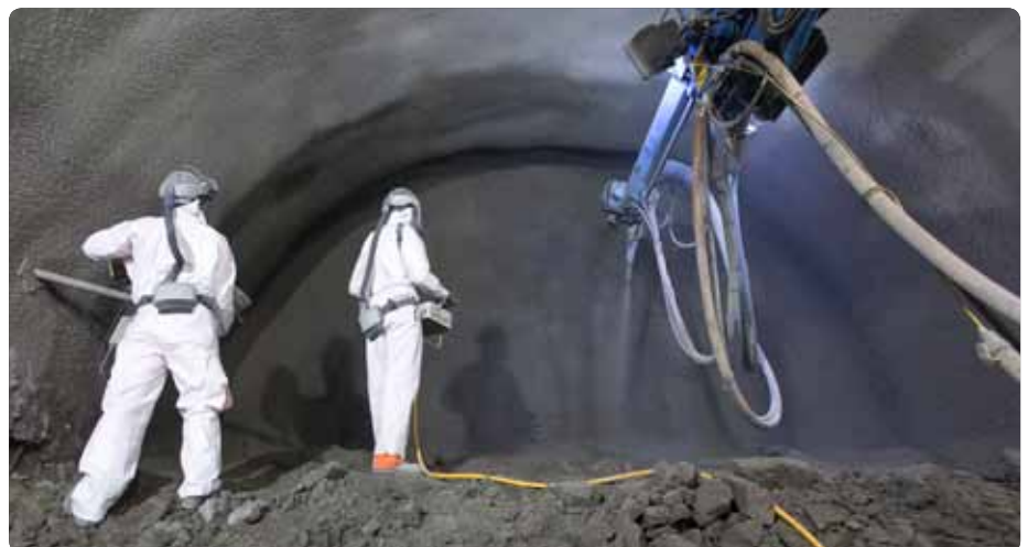
Los equipos MEYCO en diferentes obras del proyecto Crossrail, incluyendo la estación Liverpool Street (foto en la portada de este número). Todas las fotos de obras: Crossrail.
