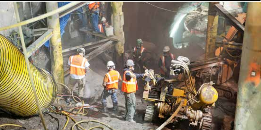
チャレンジ:86丁目プロジェクトの北端で作業するオペレータとアトラスコプコのクローラードリル
