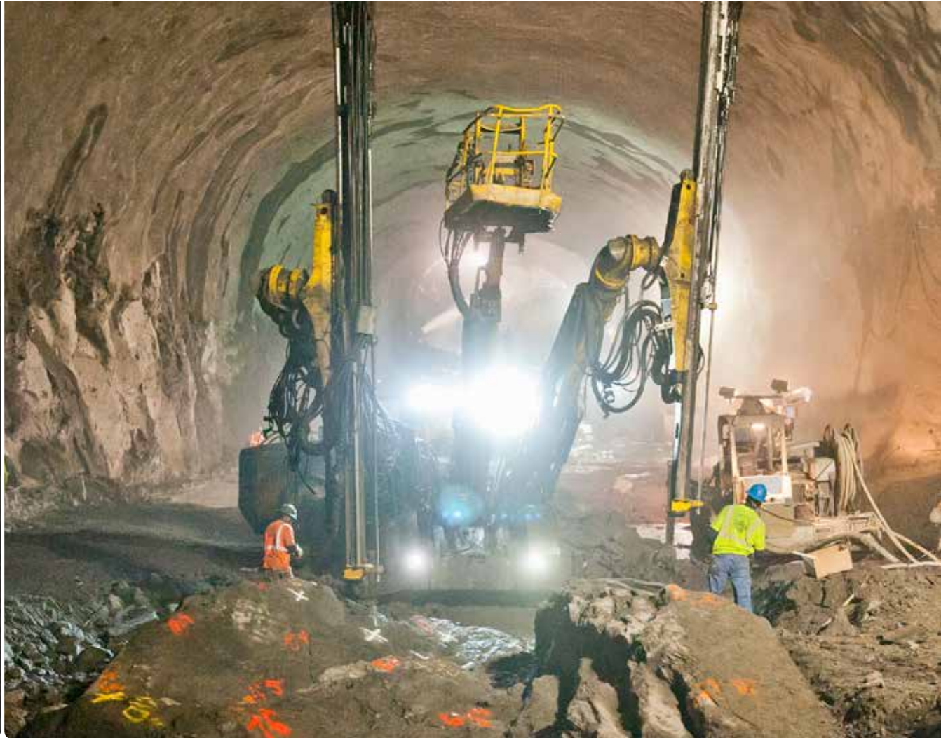
北立坑のベンチ形成: Boomer EC2(上)が垂直掘削をするスペースを確保するために、Boomer T1 Dが立坑の下部を掘削し広げていきました。
