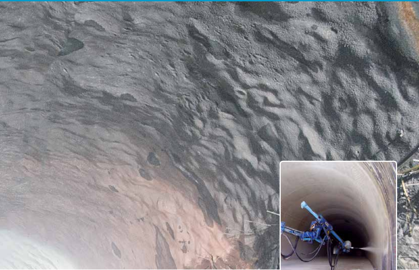
見かけ以上の技術： 鉱山やトンネルの岩盤に使用される、一般的な灰色吹付けコンクリート。吹付け能力が大きいことから、昨今のトンネルでは湿式工法のみが採用され、MEYCOのロボットリグは湿式に最適な働きをします。
