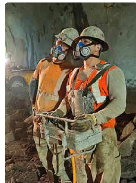
全神経を集中して:Supremaを遠隔操作し、最終の防護層を吹付け施工するMEYCOオペレーター
