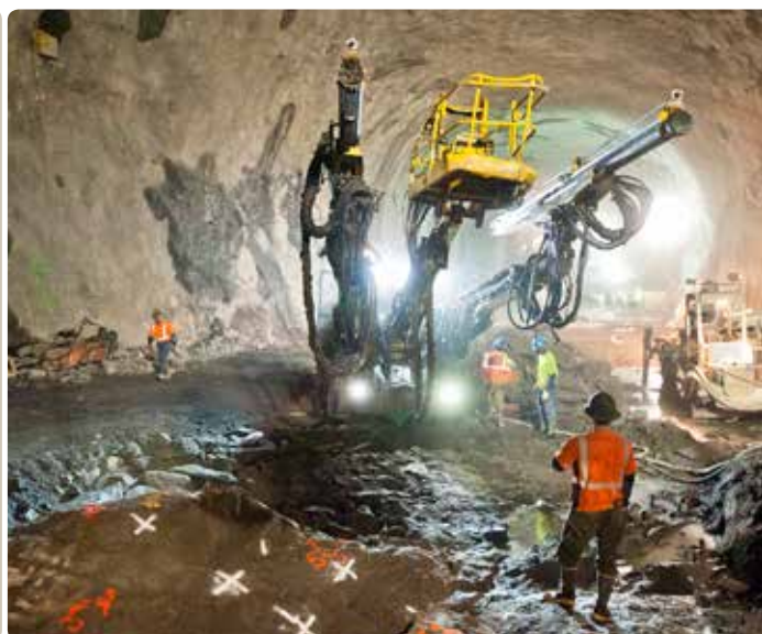
始動:地下空洞の先進導坑を掘削する Boomer E2C
