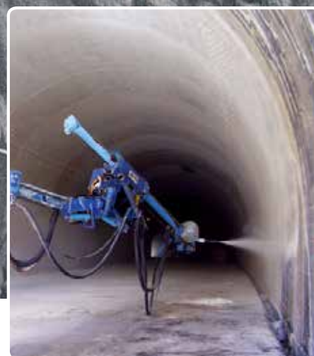
見かけ以上の技術： 鉱山やトンネルの岩盤に使用される、一般的な灰色吹付けコンクリート。吹付け能力が大きいことから、昨今のトンネルでは湿式工法のみが採用され、MEYCOのロボットリグは湿式に最適な働きをします。
