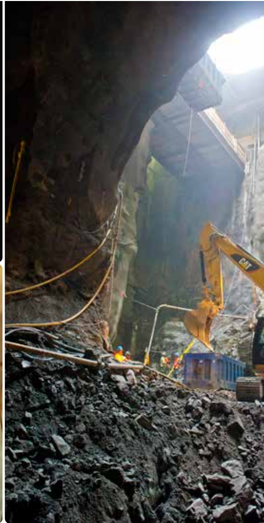
出口は上のみ発破後、1日あたり700~1000トンのズリがコンテナに詰められ、地上に吊り上げられていきます。
