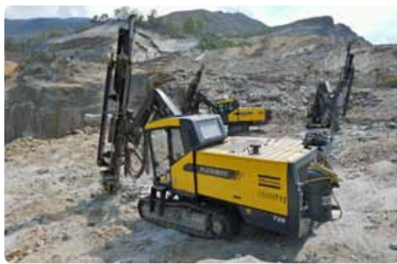
En la superficie: El perforador FlexiROC T35 trabaja sobre y bajo tierra.
