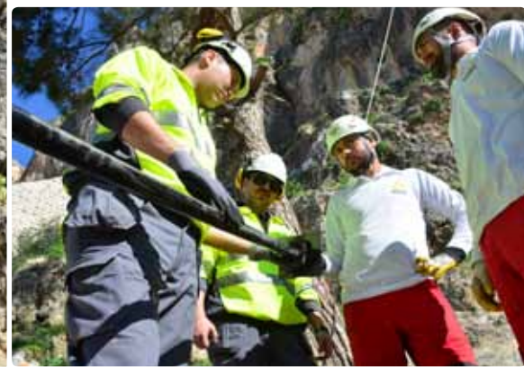
Deyvi Akkris y Bahadır Ergener, Ingeniero de Ventas y Gerente de Línea de Negocios de Atlas Copco, muestra al equipo la forma de instalar el Swellex Pm24. Derecha: la bomba Swellex APSP 300 es alzada hasta su posición.
