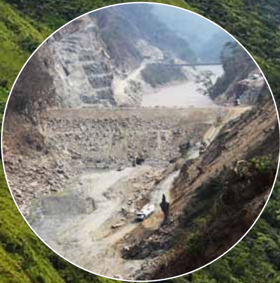
Construyendo la presa de Ituango.
