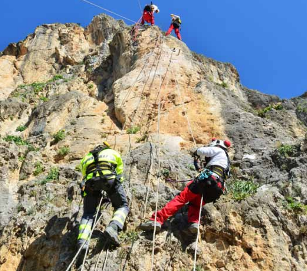
Swellex al rescate: Estos montañistas tuvieron que descollarse por la ladera de la montaña para alcanzar la sección de roca suelta y que amenazaba con caer sobre la famosa iglesia caverna de San Pedro.
