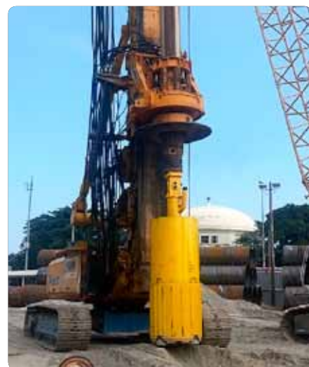
La perforadora de cluster es bajada a la posición para empezar el primer pozo en el puente Rio Barra.
