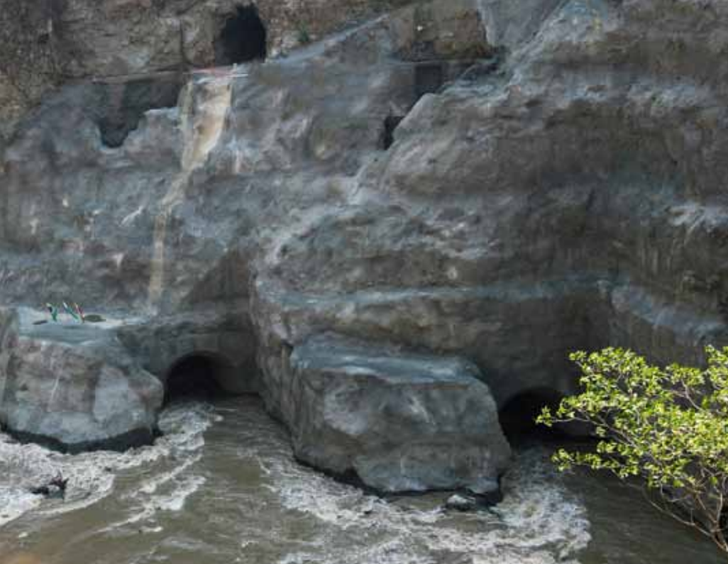
La potencia del río Cauca: Vista de los portales de los túneles de admisión temporarios.
