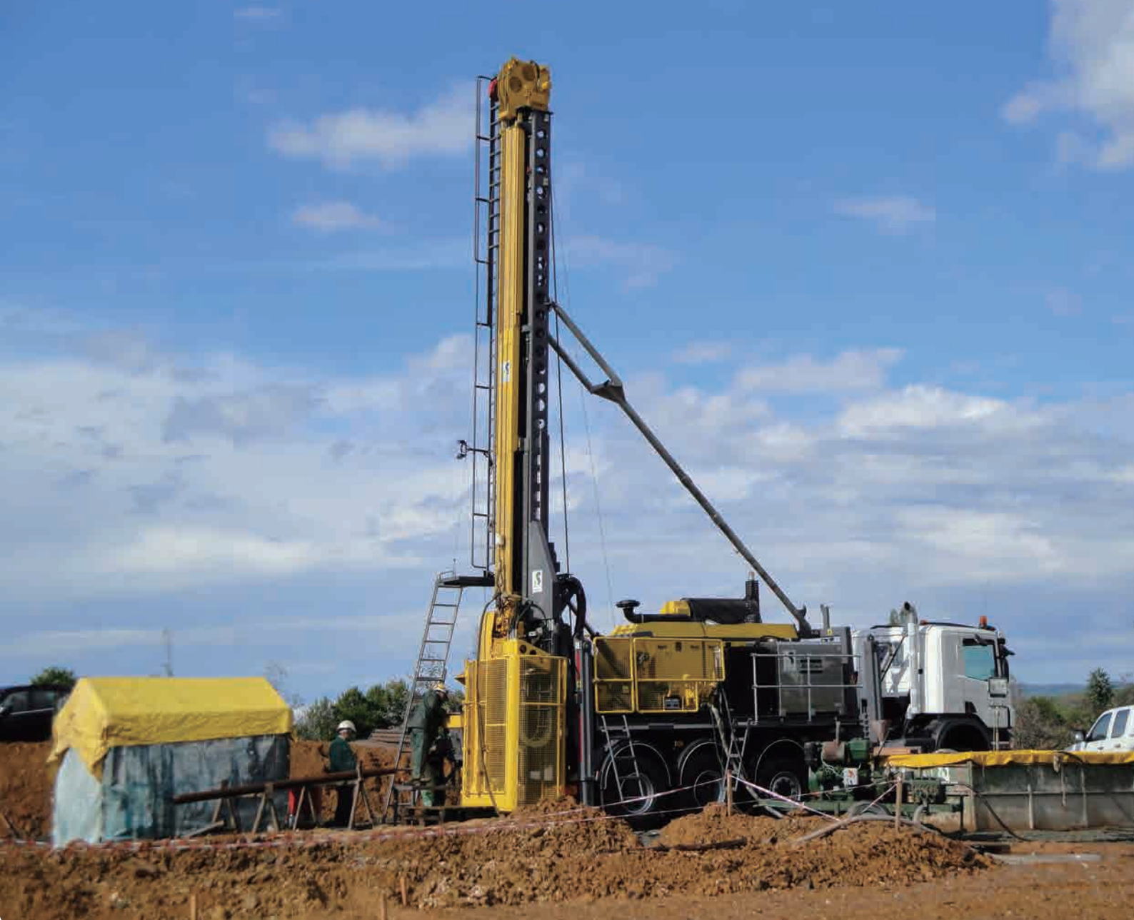
アトラスコプコChristensen CT20明かり用コアドリリングリグ:スペイン南部のリオ・ティント鉱山で、当初は持っている性能を存分に発揮できませんでしたが、さく孔条件の調整とオペレーターのトレーニングにより、予想を超える結果を上げることができました。
