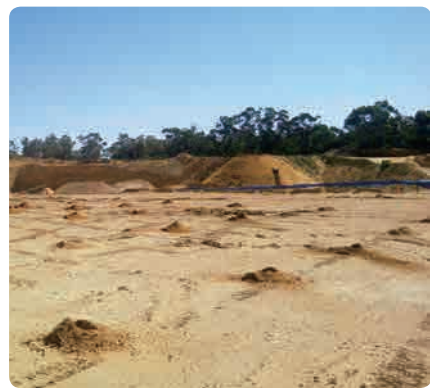
任務完了!完全自動化の遠隔操作で、15孔(5孔×3列)のドリルパターンをせん孔完了
