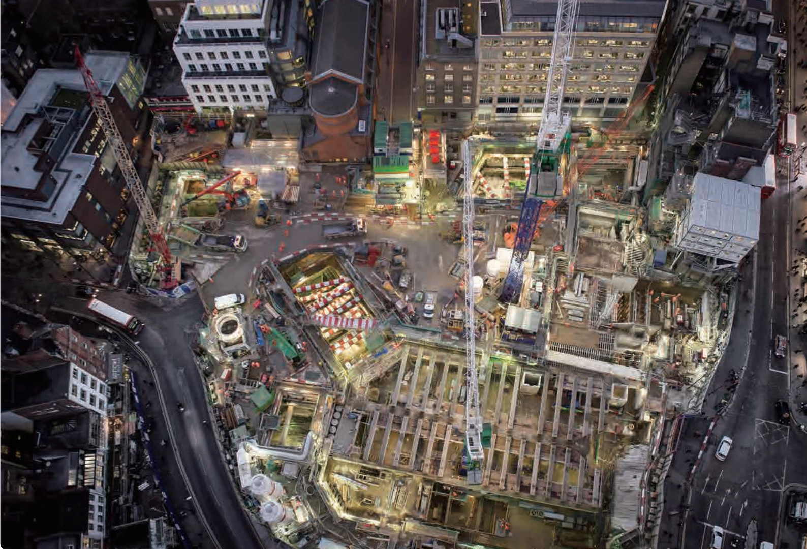
現場の全景:トットナム・コート・ロード駅の改造工事は大がかりですが、ロンドンの地下鉄網全体をアップグレードするという壮大なプロジェクトから見れば、ほんの一部に過ぎません。プロジェクト全体での現場は40を数え、工事に従事する関係者は1万人に上ります。ヨーロッパで最大の建設プロジェクトになると言われています。
