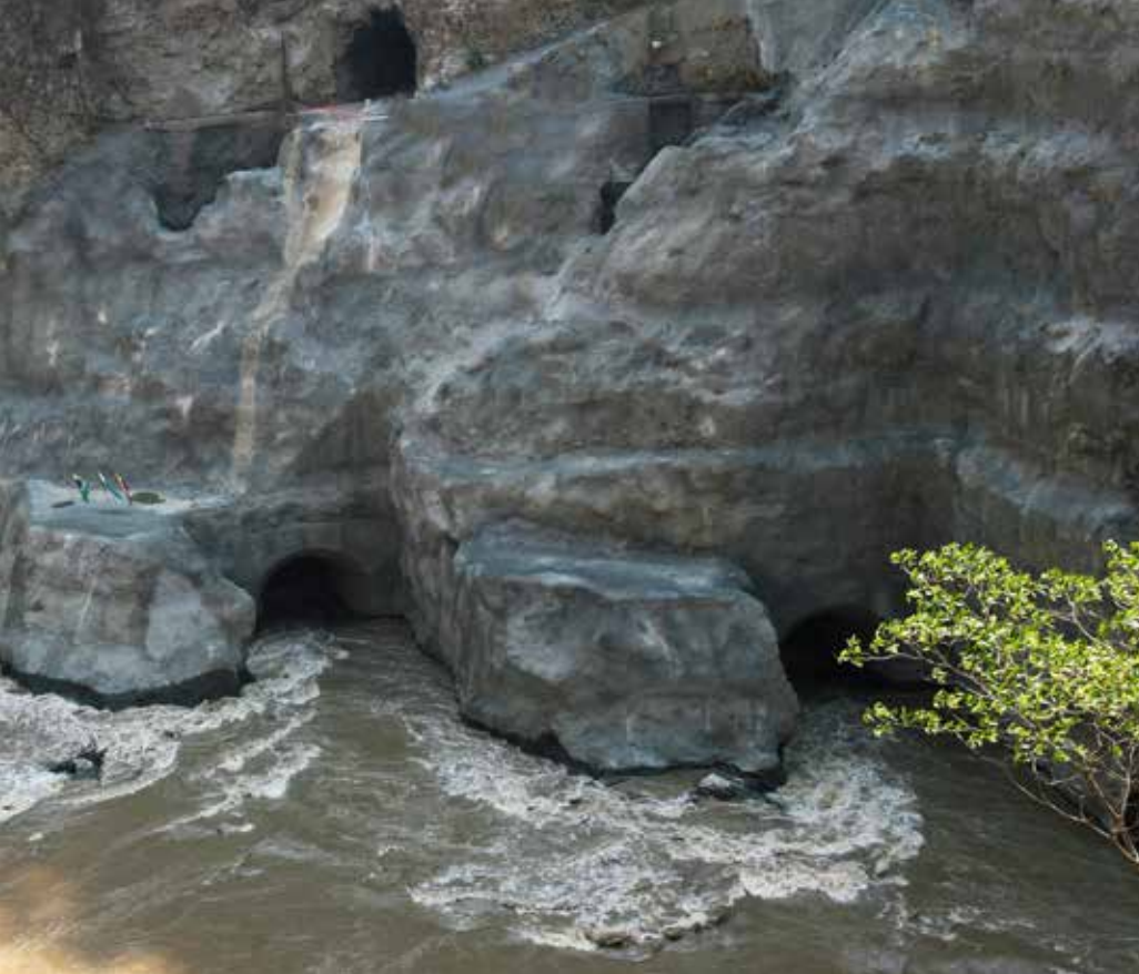
カウカ川の水のパワー：一時的な切り回し用の取水トンネルの坑口
