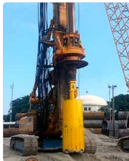
リオバーラブリッジで最初に掘削する位置まで下げられるクラスタドリル
