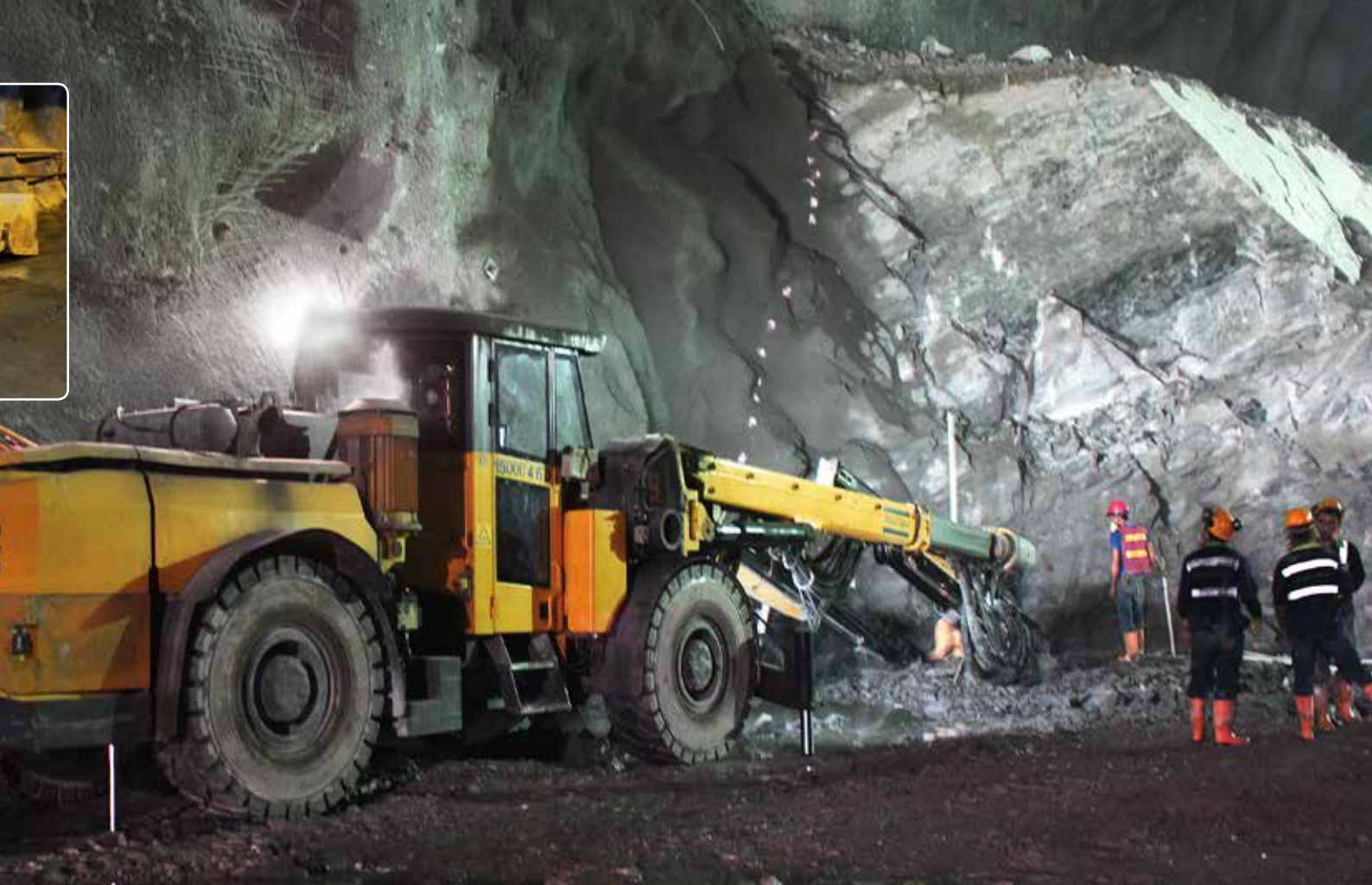
より多くのエネルギーを、イツァンゴでトンネルと空洞を掘削する2ブームのアトラスコプコBoomer E2 C ドリルリグ。 イツァンゴ水力発電所の建設により、コロンビアの電力供給はさらに2400MW増加する予定です。
