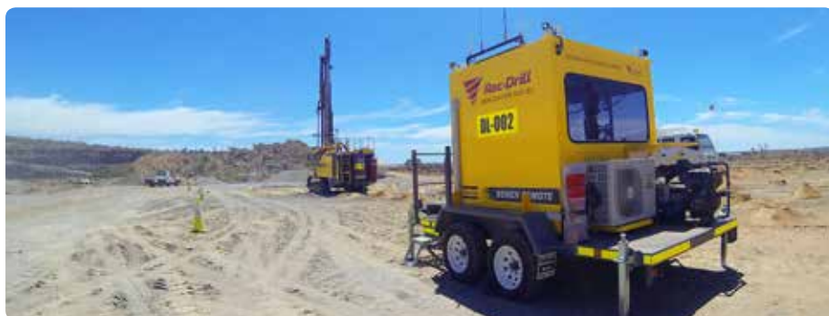
2014年の半ばから発売されます。ベンチリモート (BenchREMOTE) ステーションがあれば、クローラドリルのオペレーターは何が起きるか分からない危険な現場ではなく100mほど離れた安全な場所でリグを操作出来るようになりました。
