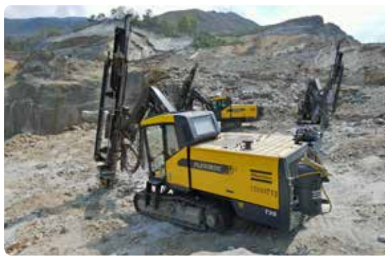
地上で: 明かりと坑内で活躍するFlexiROC T35 クローラドリル
