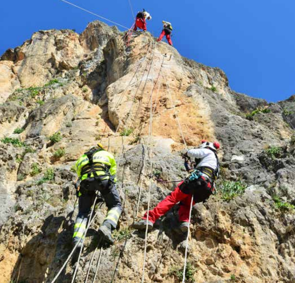
救いの手はSwellex：緩んでもろくなり、聖ペテロ洞窟教会に落下する危険のある岩盤を目指し、登山家たちは懸垂下降していきま
