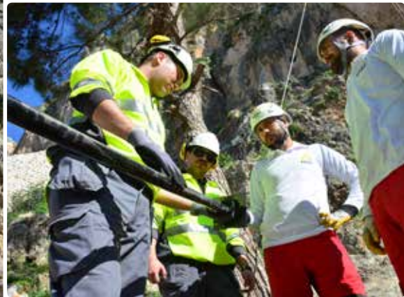
アトラスコブコ セールスエンジニアのデイビッド・クリスト、ビジネスラインマネージャー パハディール・エルゲネールはSwellex Pm24の打設法の指導にあたりました。右：所定の位置まで吊り下げられ移動するAPSP 300 Swellex ポンプ
