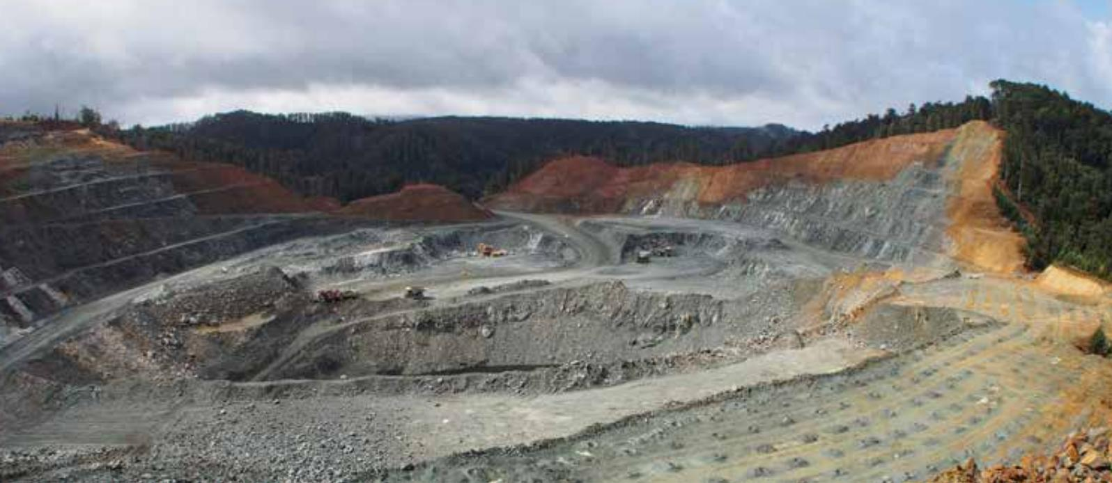
萨维奇河矿全景图：该地区的强降雨有时会影响台阶的稳定性。阿特拉斯·科普柯的BenchREMOTE系统允许操作人员在安全距离操作SmartROC D65钻机。
