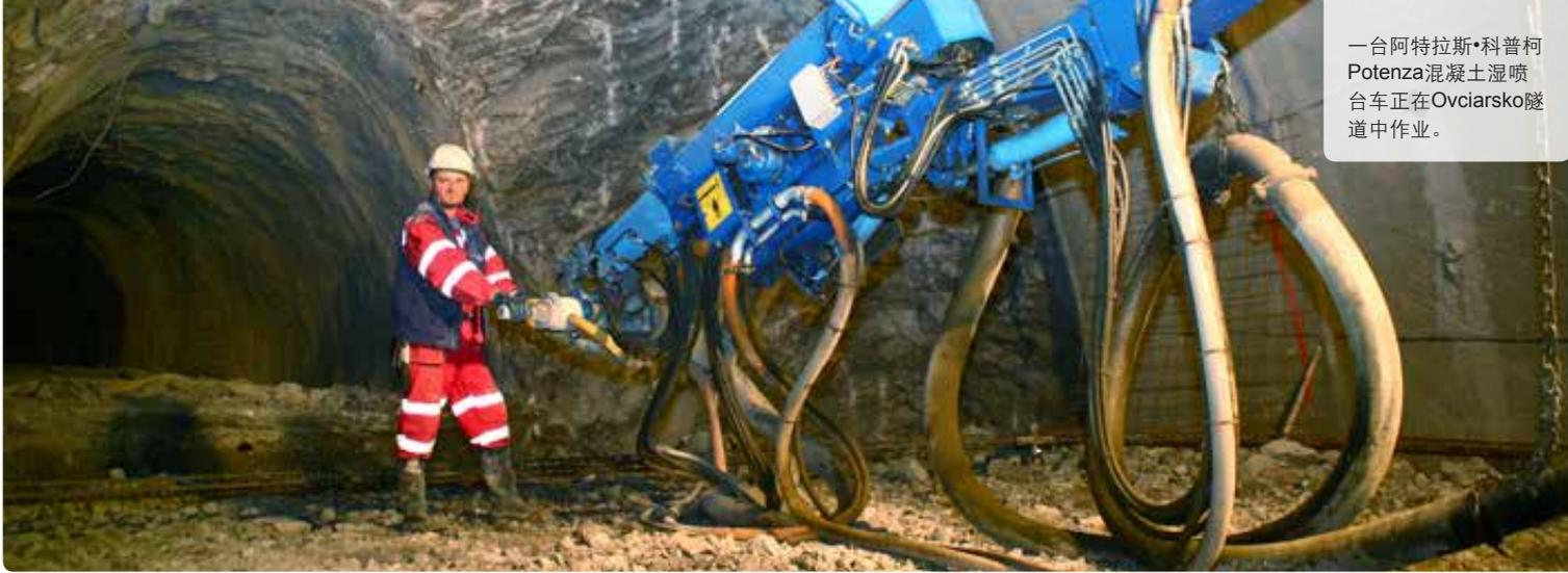
一台阿特拉斯·科普柯 Potenza 混凝土湿喷台车正在Ovciarsko隧道中作业。
