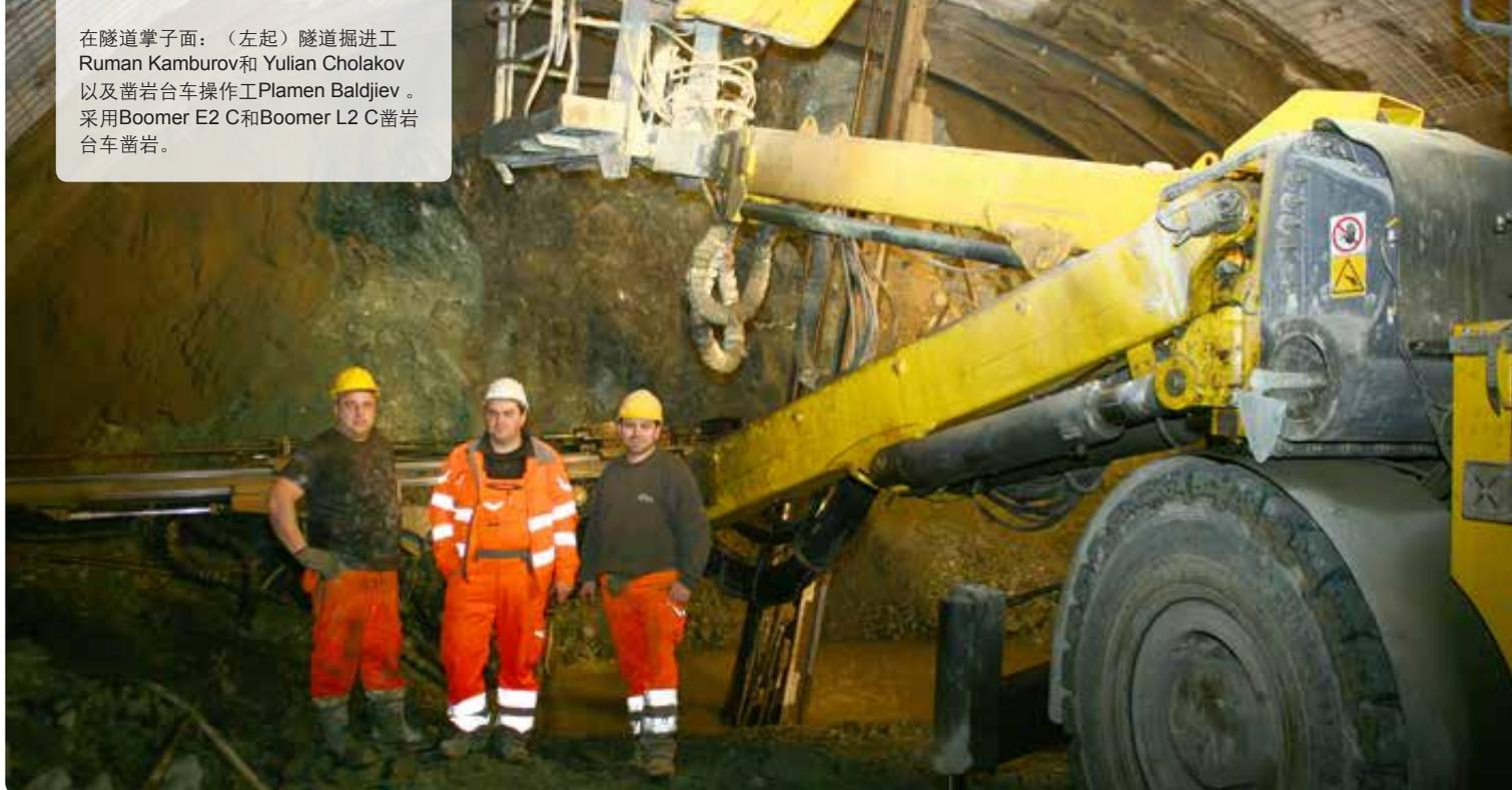
钻爆法施工。在松散岩层中，采用液压破碎锤和挖掘机施工。
