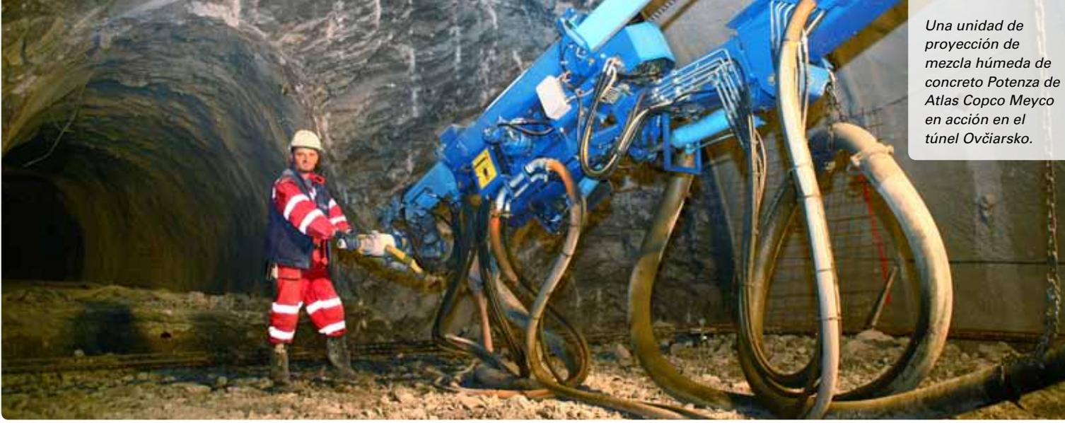
Una unidad de proyección de mezcla húmeda de concreto Potenza de Atlas Copco Meyco en acción en el túnel Ovčiarško.
