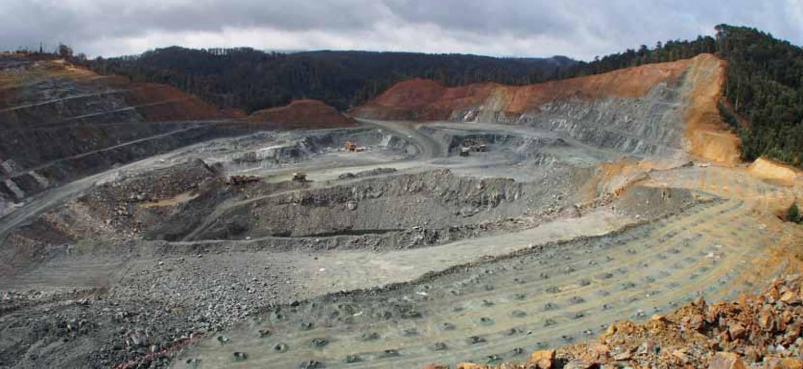
Vista de la mina Savage River: Las fuertes lluvias en el área pueden a veces afectar la estabilidad de los bancos. El sistema BenchREMOTE de Atlas Copco permite operar el equipo SmartROC D65 desde una distancia segura.
