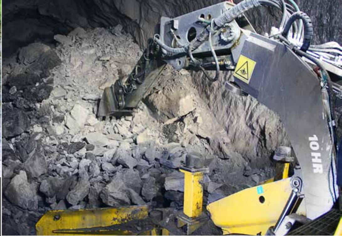
右写真:ヘグローダーのバックホーバケットがズリをすくってコンベヤーに載せています。 写真下、コンベヤーからズリを直接トラックに積み込みしています。
