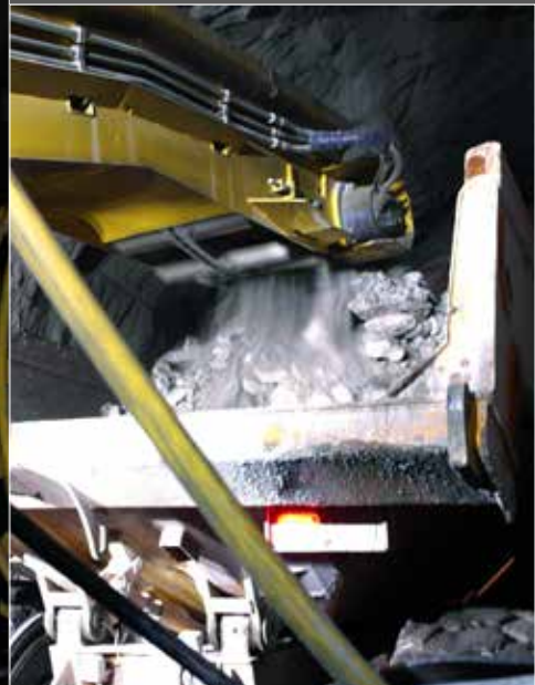
右写真:ヘグローダーのバックホーバケットがズリをすくってコンベヤーに載せています。 写真下、コンベヤーからズリを直接トラックに積み込みしています。
