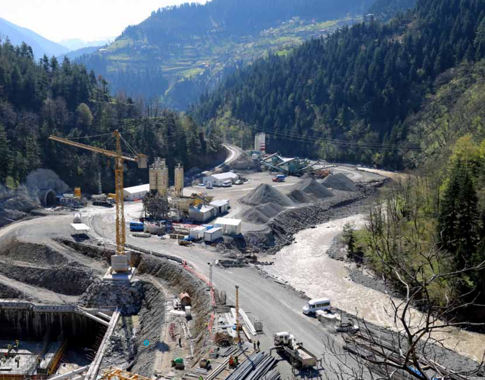
Vista general de la obra: La foto muestra el túnel de admisión (arriba al centro) y las bases de las instalaciones de la planta.
