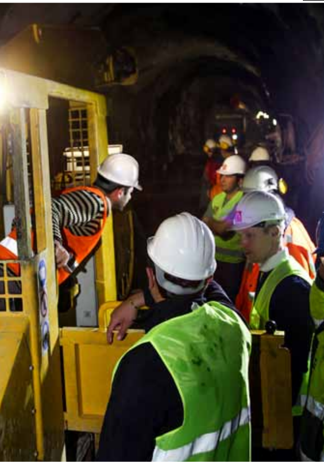
Dentro del túnel: Arriba, el equipo discute la configuración óptima en el reducido espacio del frente.
