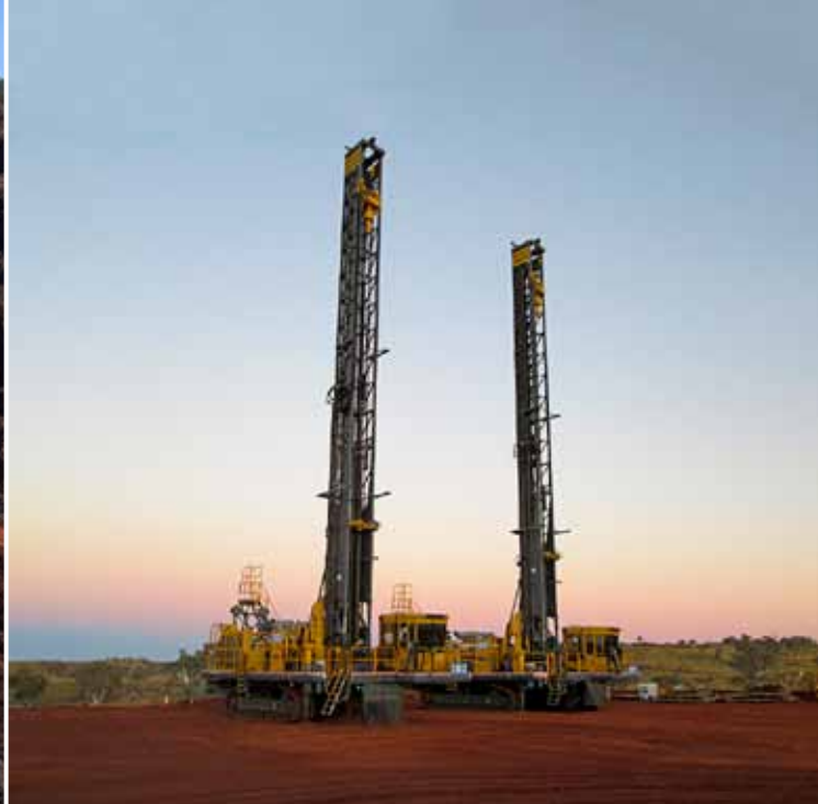
Una vista familiar en Pilbara: Equipos de perforación Pit Viper 271.
