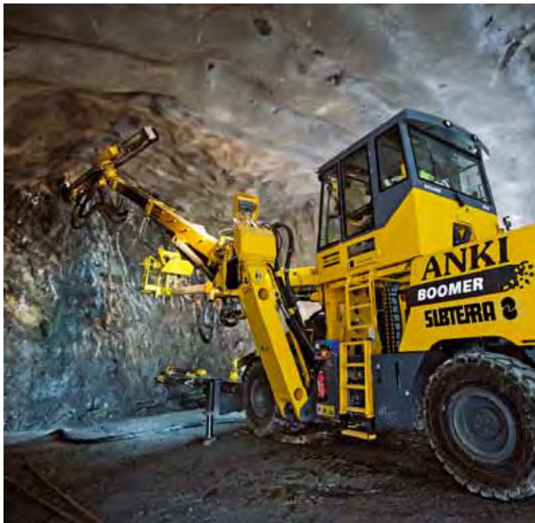
El bypass en marcha: El Boomer WE3 en acción en los túneles de acceso.
