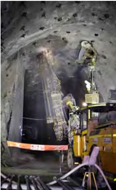
La prueba comienza: El Boltec MC en la mina El Teniente.
