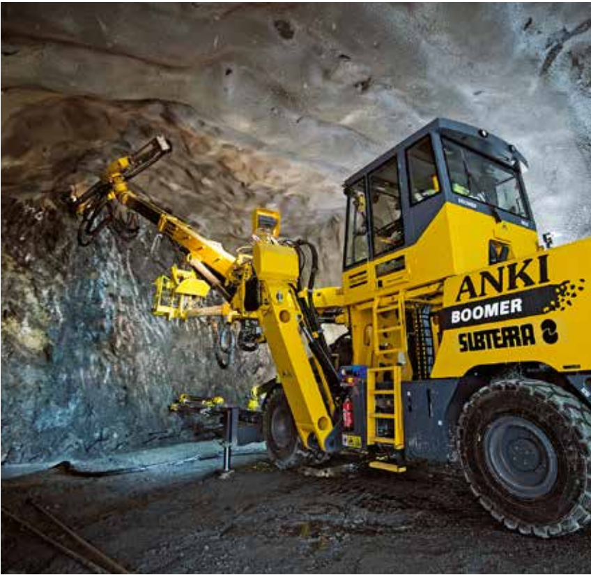
バイパス施工開始:進入坑で稼働中のBoomer WE3
