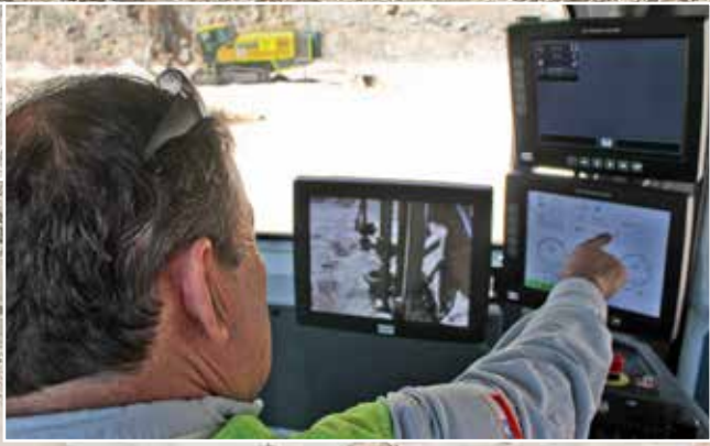
時代の移り変わり:オペレーター(右)は離れた安全な場所から機能を全てコントロールし、SmartROC D65ダウンザホールドリルリグ(左)は無人で掘削作業中
