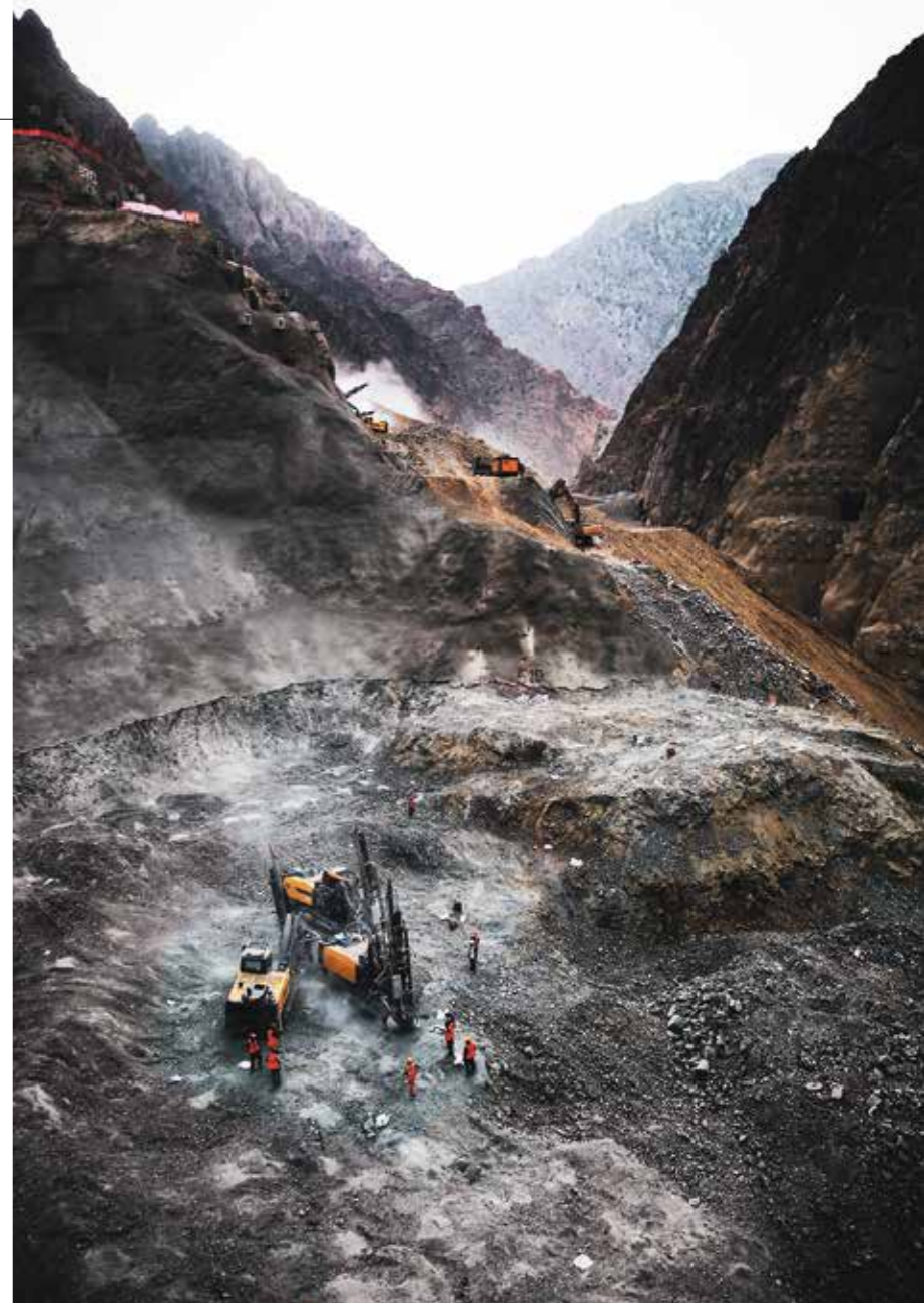
尤素费里坝主体要降低275米。SmartROC T40钻机是成功的关键。
